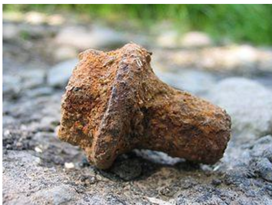
Slika 1. Primjer vijka koji je pod djelovanjem korozije [43]
