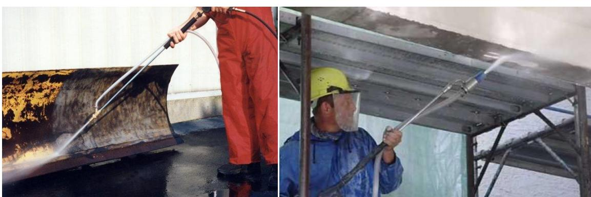
Slika 27. Priprema površine vodenim mlazom [52, 53]
