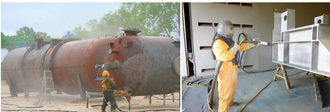
Slika 28. Priprema površine pjeskarenjem[37, 38]
