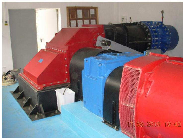
Slika 5.8. kućišta crossflow turbine
