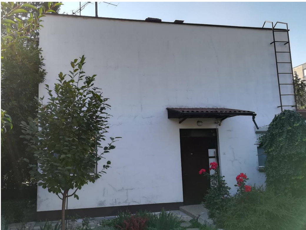
Slika 2.1. Kuća u gradu Varaždinu
