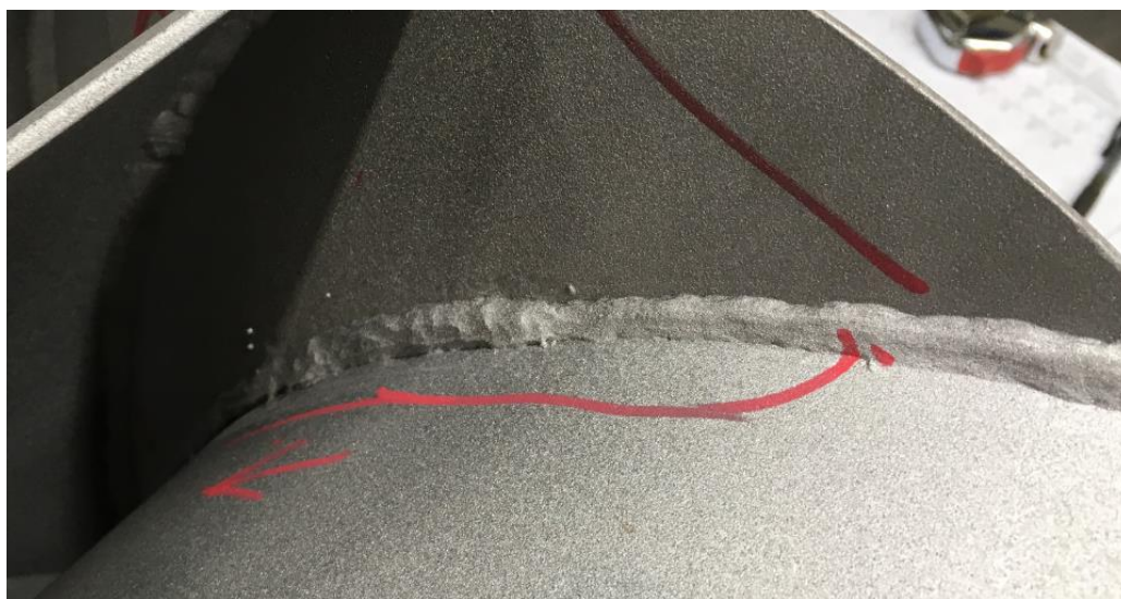
Slika 11: Naljepljivanje utvrđeno vizualnom kontrolom
