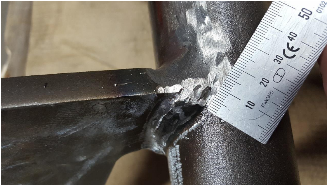
Slika 86: Označavanje i mjerenje dužine greške na zavarenom spoju
