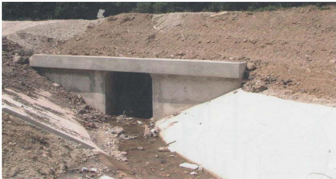
Slika 32. Pločasti betonski propust
