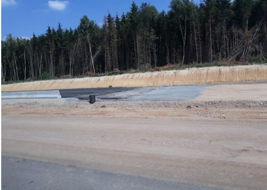
Slika 7 Završni sloj nasipa- posteljica- asfalt
