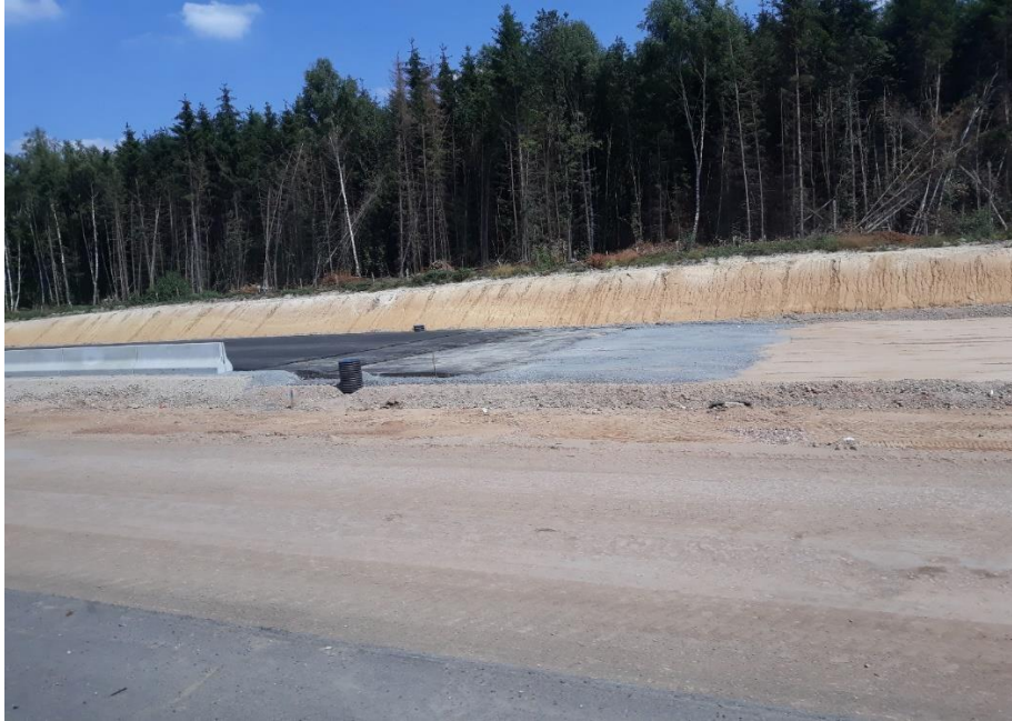
Slika 7 Završni sloj nasipa- posteljica- asfalt
