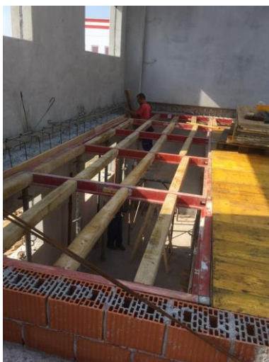
Slika 6. Postavljanje oplata za betoniranje ploče
