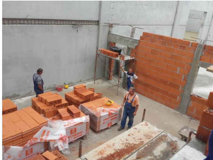
Slika 11. Priprema za zidanje iznad nadvoja
