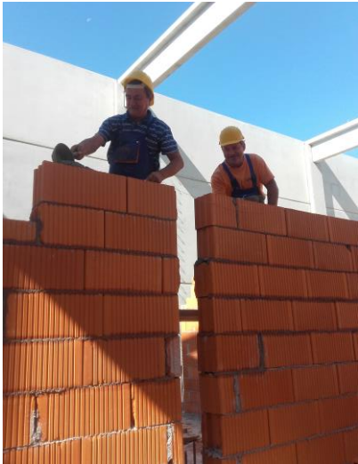
Slika 10. Zidanje nosivih zidova
