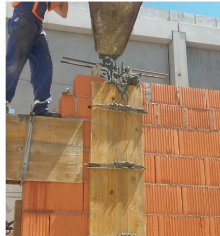
Slika 5. Betoniranje vertikalnih serklaža
