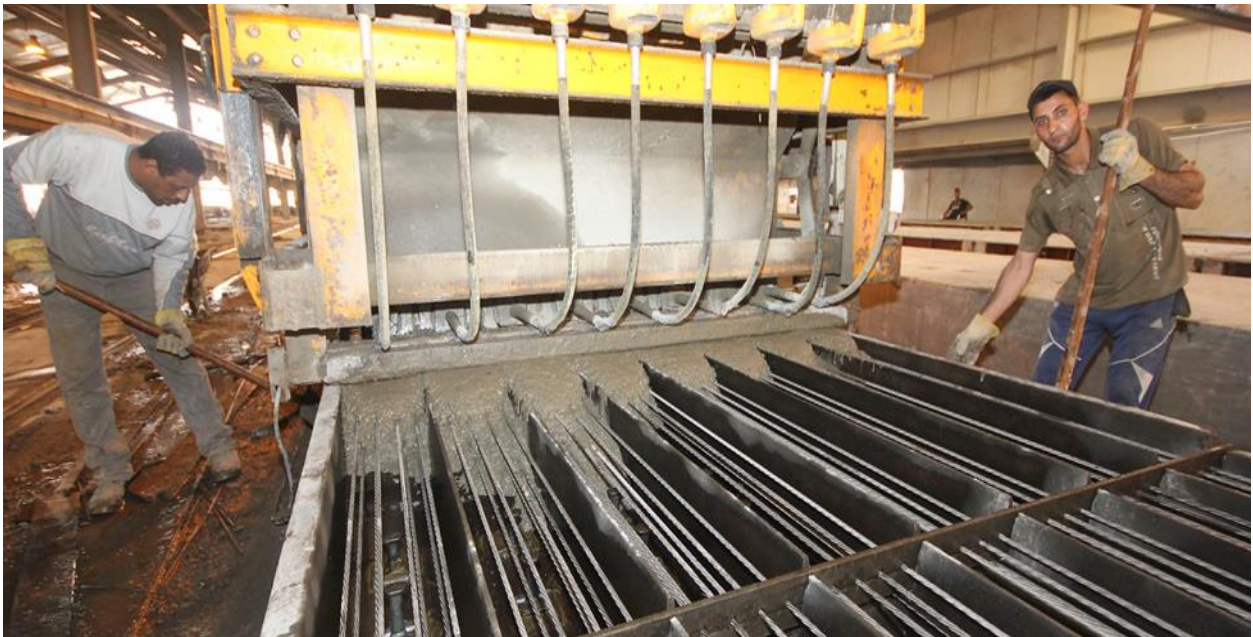
Slika 4.5 Ulijevanje betona u kalupe nakon zatezanja žica
