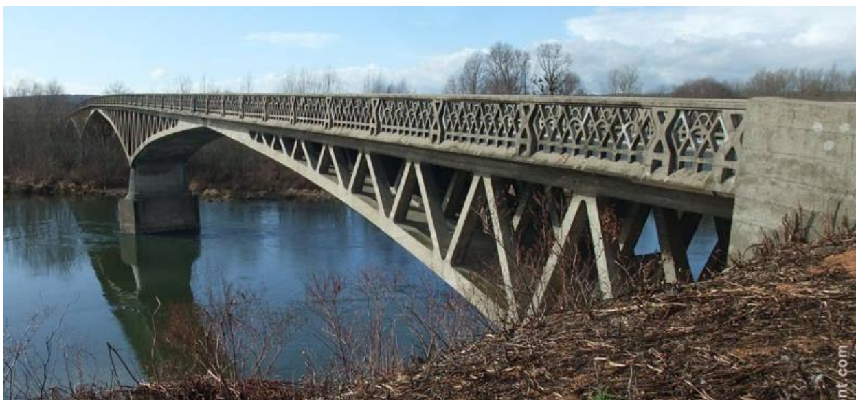
Slika 1.1 Most Pont de Boutiron na rijeci Allier
