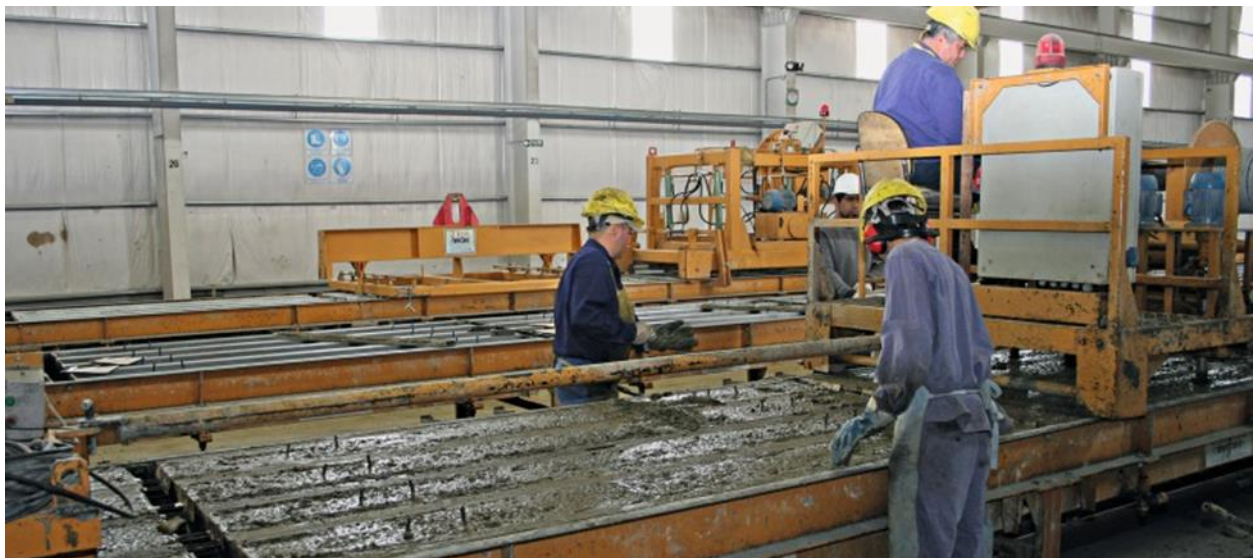
Slika 4.6 Poravnavanje betona nakon zalijevanja
