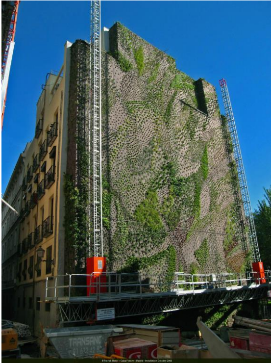
Slika 2.3.2.2.a) Instalacija vertikalnog vrta, listopad 2006.g.
