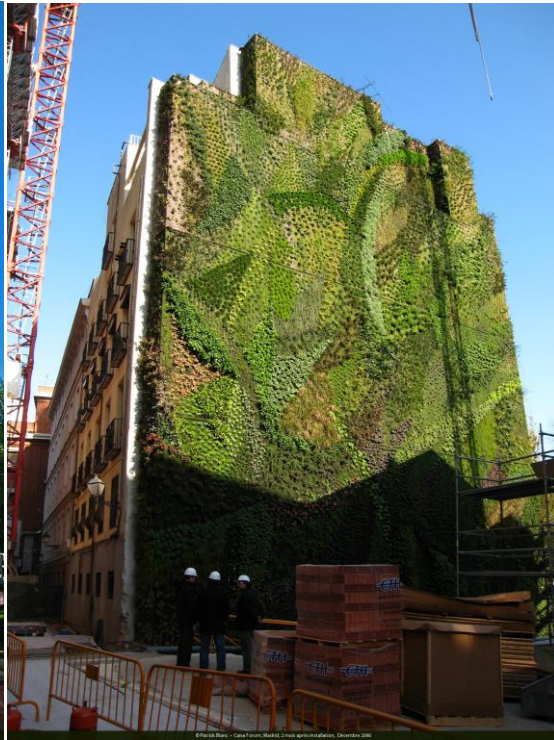
Slika 2.3.2.2.b) Dva mjeseca nakon instalacije, prosinac 2006.g.
