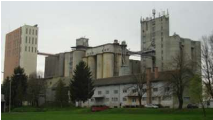
Slika 9: Silos u "Đuro Salaj"
