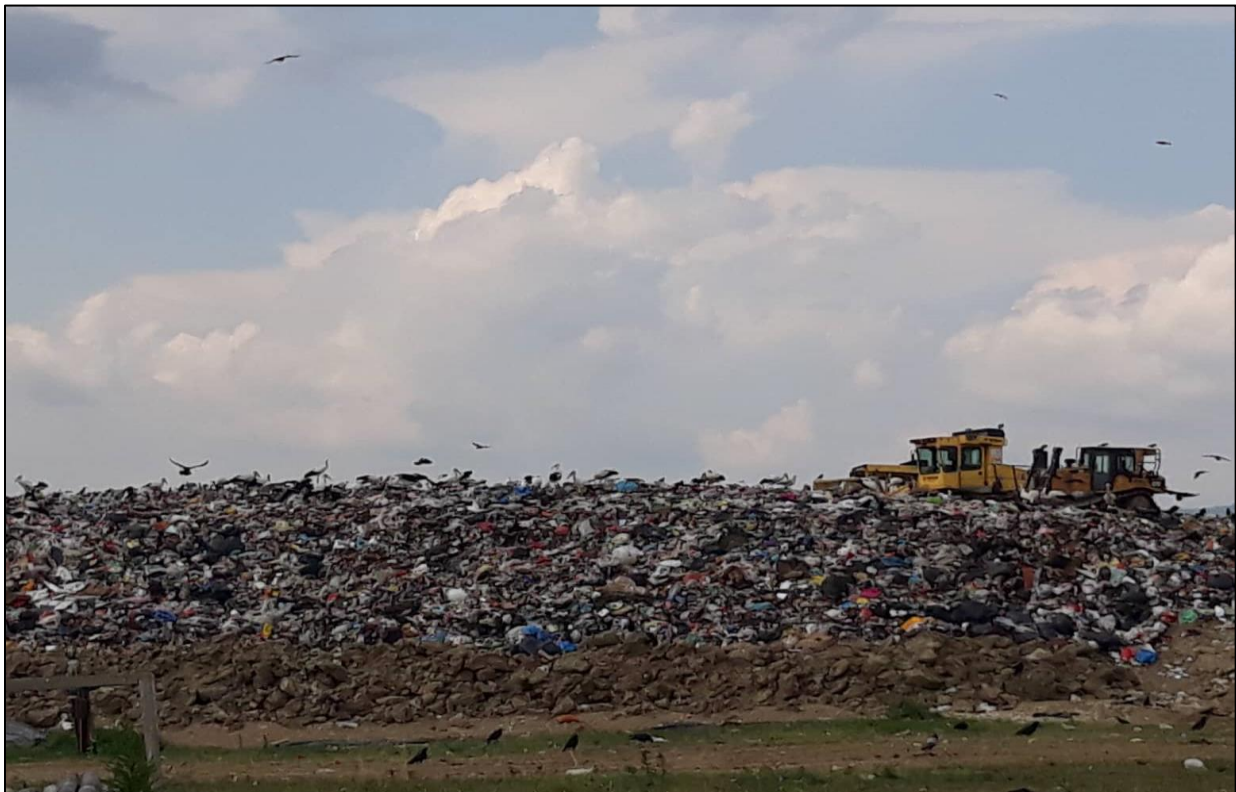
Slika 4.2. Istovarna ploha nakon istovara smeća i prije prekrivanja zemljom
