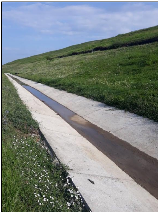
Slika 4.3. Betonski kanal za odvodnju oborinskih voda
