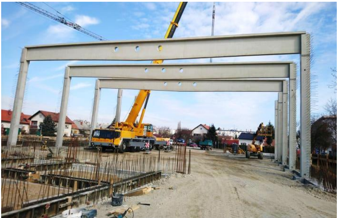
Slika 3.4 Prikaz montažnih betonskih greda ( Izvor: autor )
