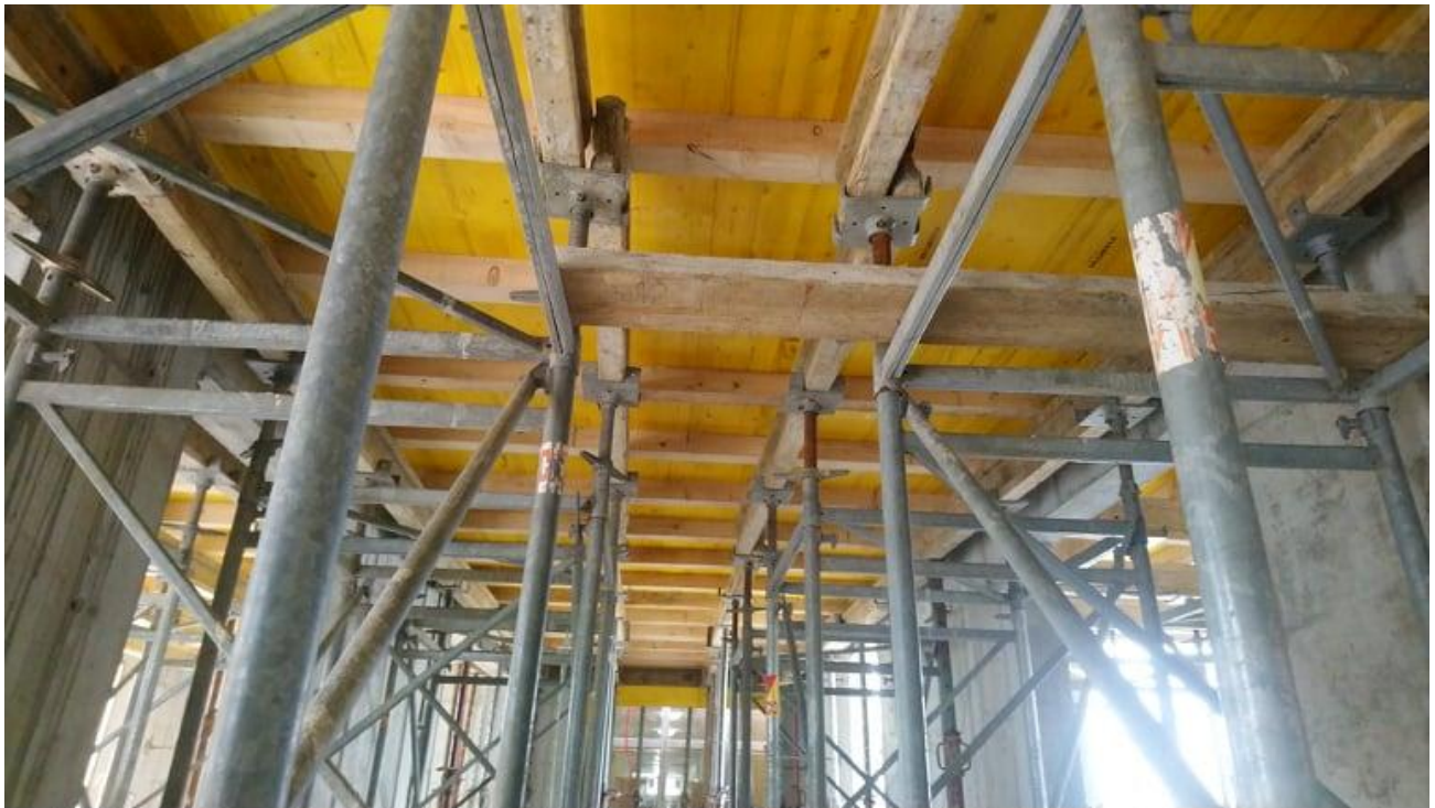
Slika 3.5 Prikaz klasične drvene oplata ( Izvor: autor )
