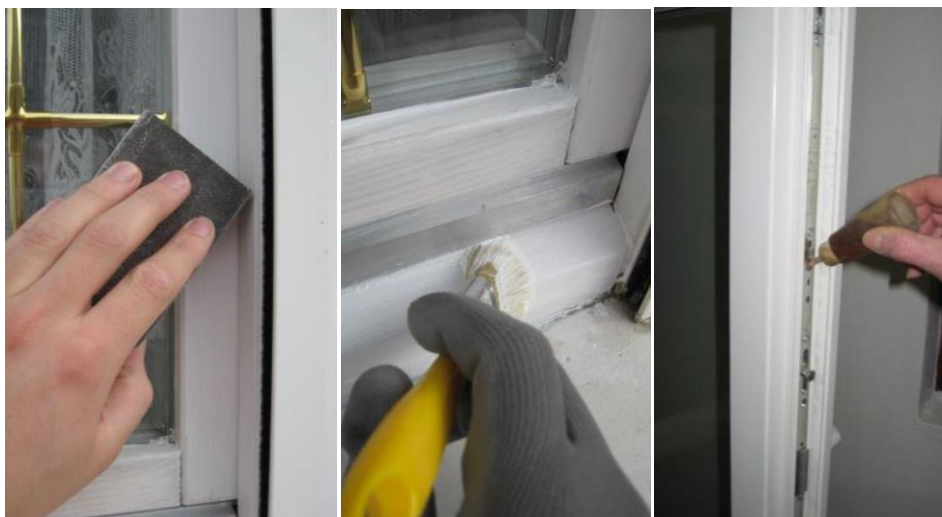
Slika 2.2. Proces održavanja drvene stolarije
