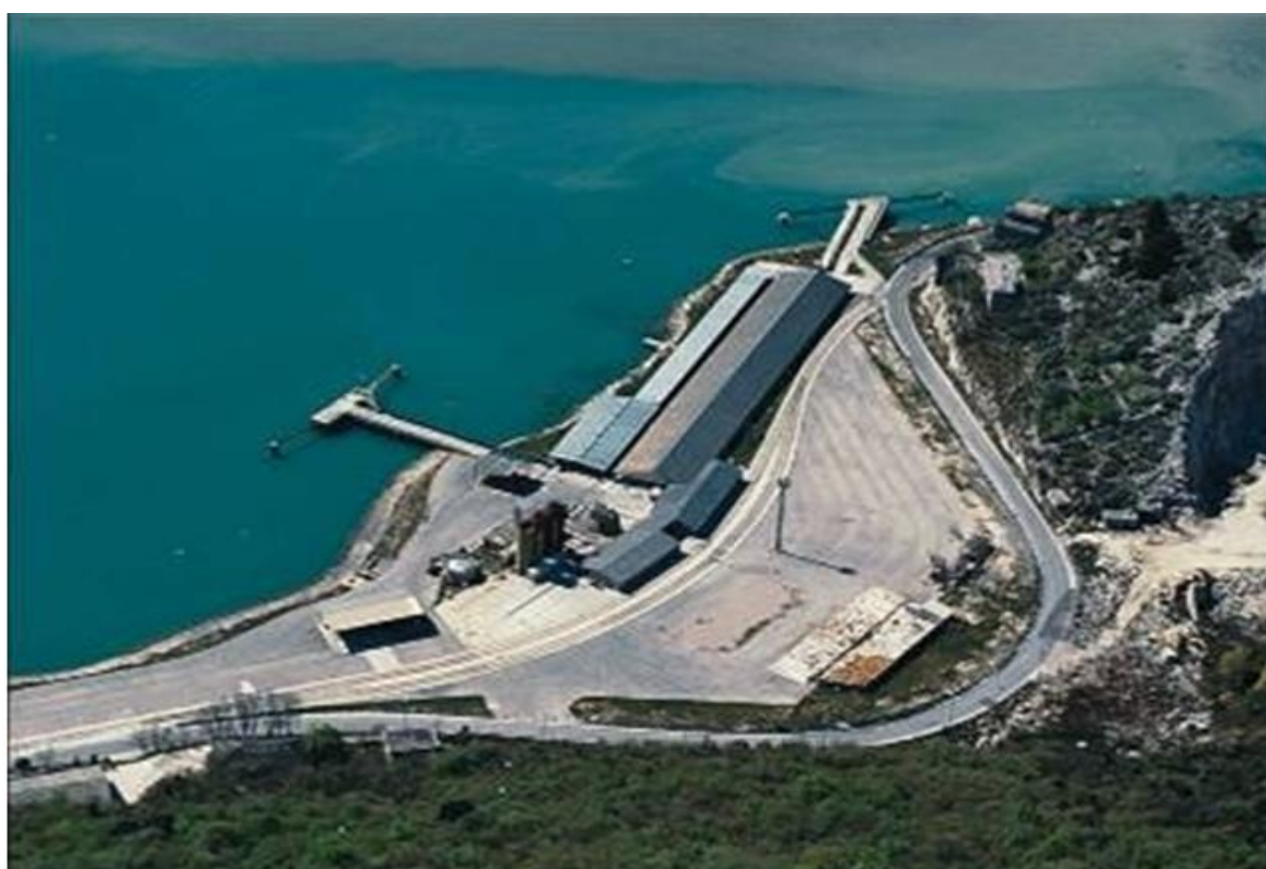
Slika 5.17. Terminal Bršica iz zraka (Izvor: https://lukarijeka.hr/ )
