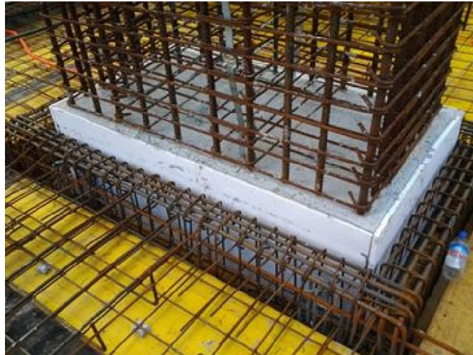
Slika 3.5 Prikaz dilatiranja stupa
