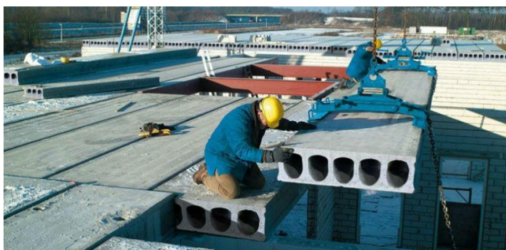
Slika 2.15 Prikaz montaže šupljih ploča
