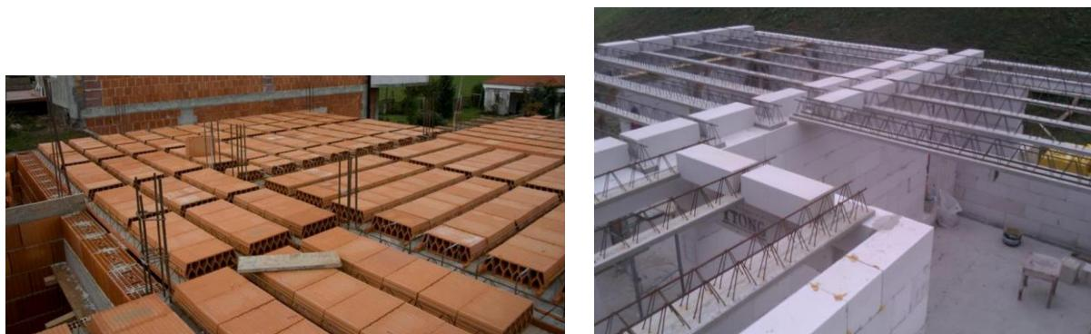
*Slika 2.18 Porotherm strop (slika lijevo) i „Bijeli strop“ (slika desno)*
