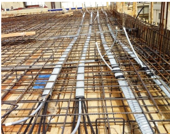
Slika 2.20 „Bonded“ i „unbonded“ kabele za prednaprezanje
