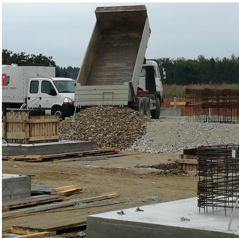
Slika 4.3. Nasipavanje šljunka oko temeljne stope
