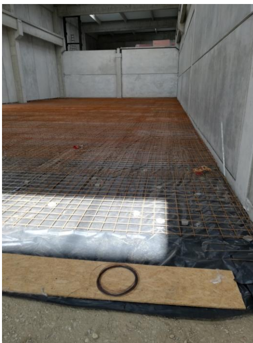
Slika 4.14. Hidroizolacija podne AB ploče PE folijom
