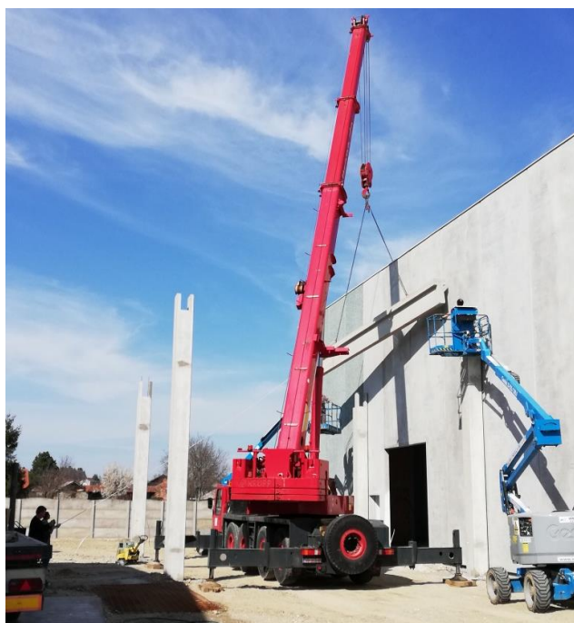
Slika 4.12. Montaža nosača nadstrešnice autodizalicom
