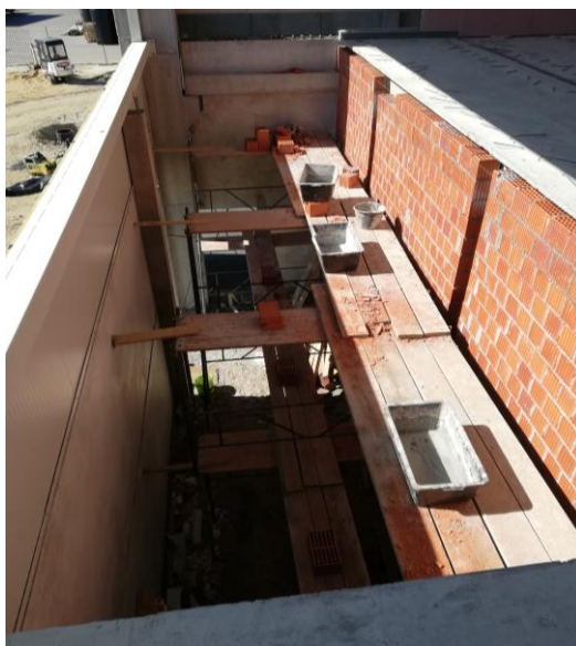
Slika 4.13. Unutarnji pregradni zidovi izvedeni šupljom opekom
