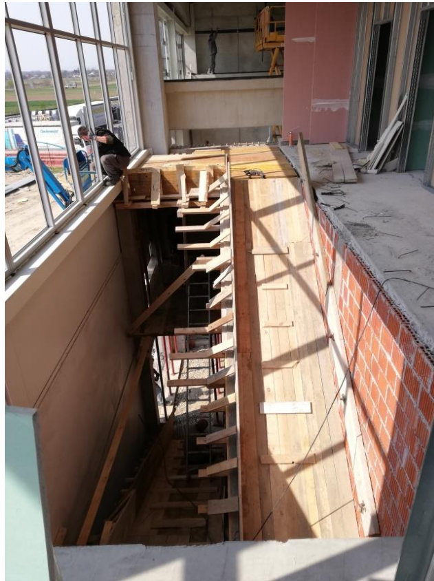
Slika 4.5. Postava oplata unutarnjeg AB stepeništa
