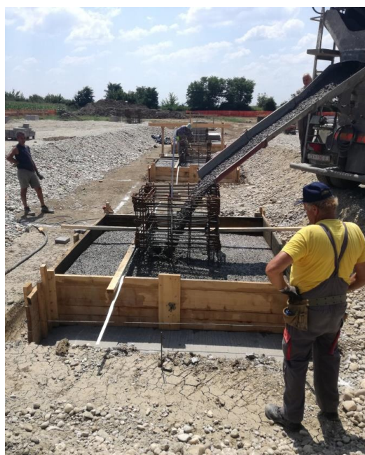
Slika 4.8. Betoniranje temeljne stope
