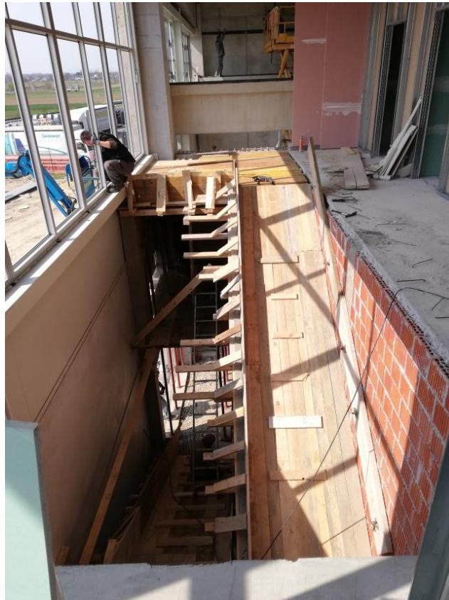
Slika 4.5. Postava oplate unutarnjeg AB stepeništa
