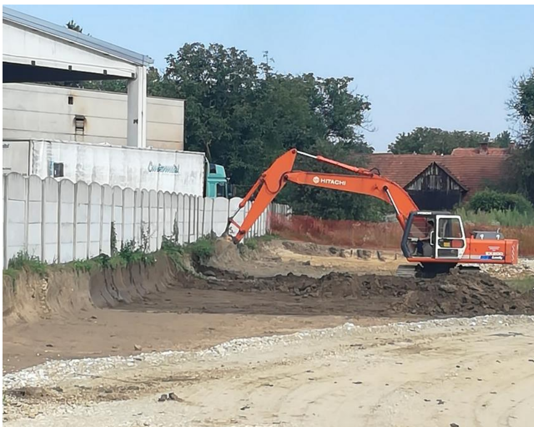
Slika 4.1. Strojni iskop materijala III. kategorije
