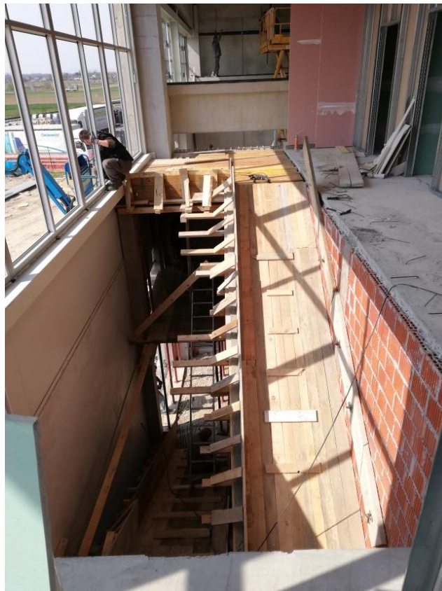
Slika 4.5. Postava oplata unutarnjeg AB stepeništa
