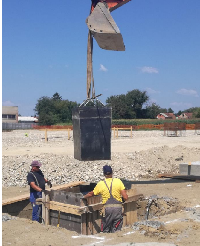
Slika 4.6. Čelična oplata temeljnih čašica
