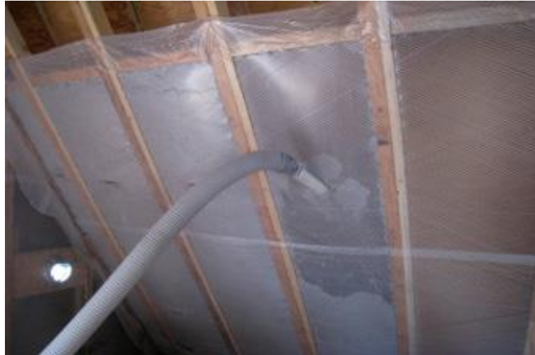
Slika 4.12 Ugradnje celuloze metodom upuhivanja
