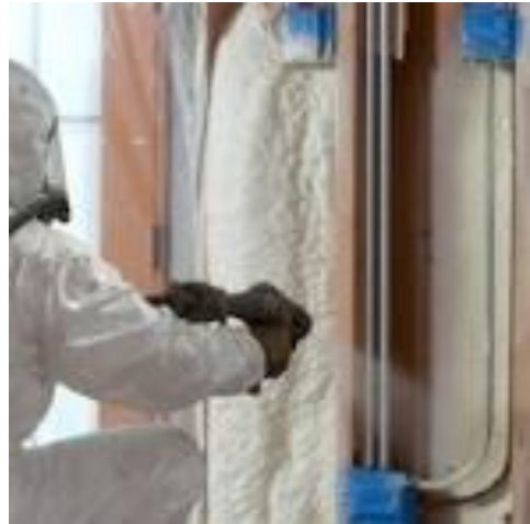
Slika 4.9 Metoda prskanja poliuretanske pjene pištoljem
