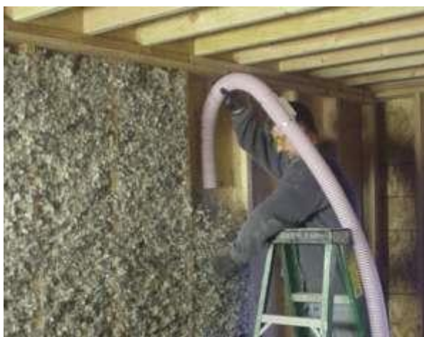
Slika 4.21 Ugradnja ovčje vune
