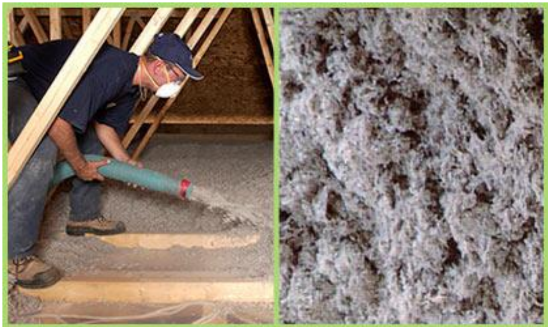
Slika 4.13 Ugradnja celuloze metodom špricanja
