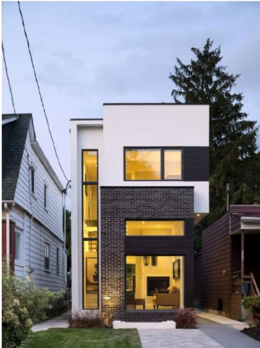
Slika 4.25 Kuća sa nano izolacijskim materijalima u Torontu
