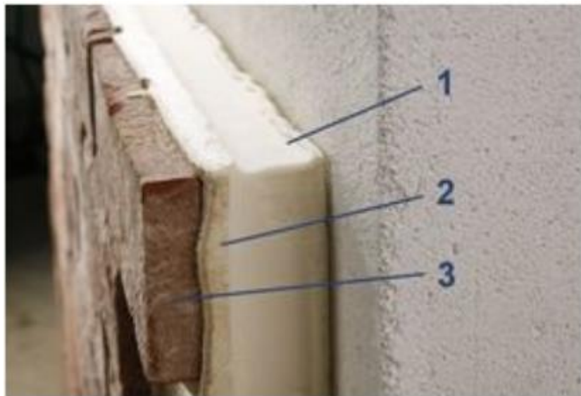
Slika 4.10 Panel s izolacijom od poliuretanske pjene (1-poliuretanski izolacijski sloj, debljine 40mm; 2-kvarcni pijesak; 3-sloj opeke debljine 20mm)
