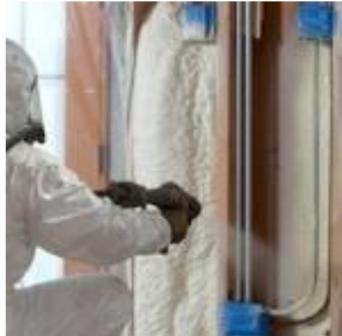
Slika 4.9 Metoda prskanja poliuretanske pjene pištoljem
