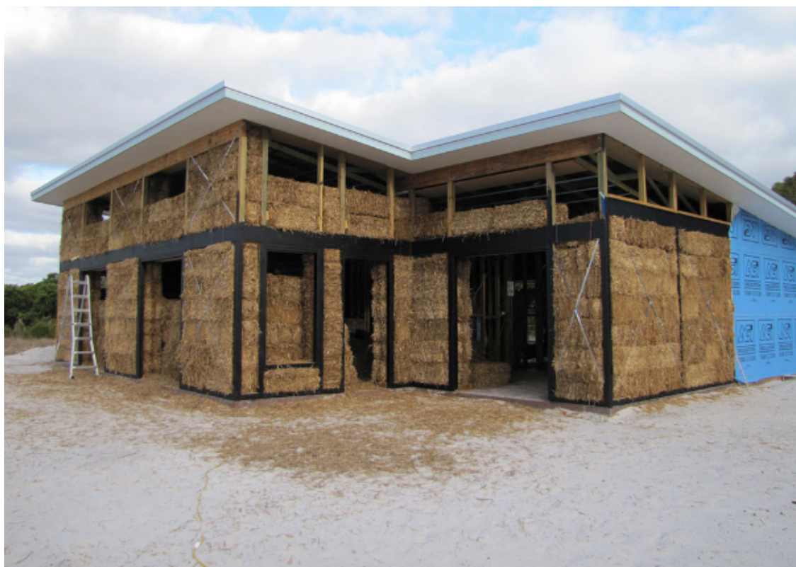
Slika 3.3 Slama izolacijska ispuna
