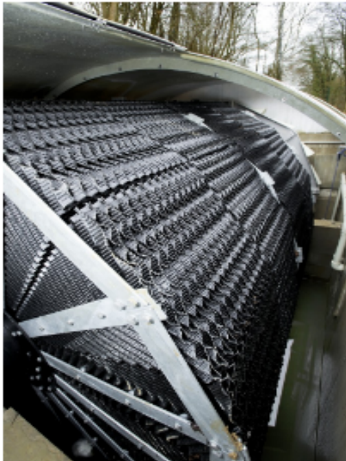
Slika 3.6 Biorotor
