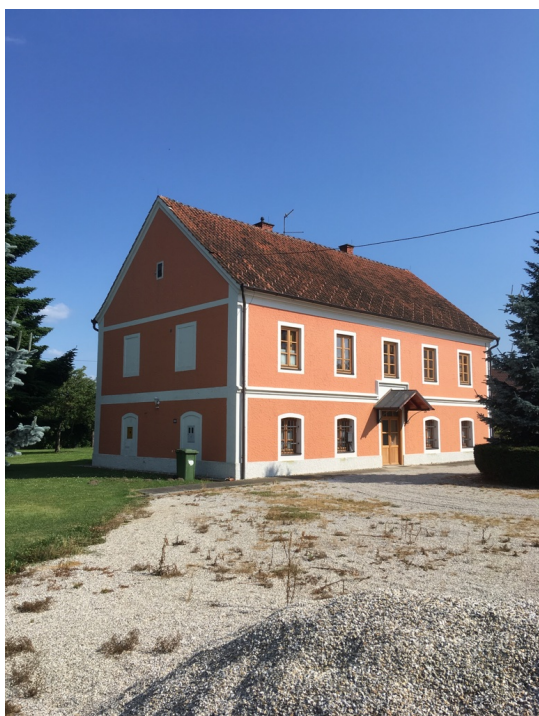
Slika 2.22 Sjeverozapadna strana Župnog dvora
