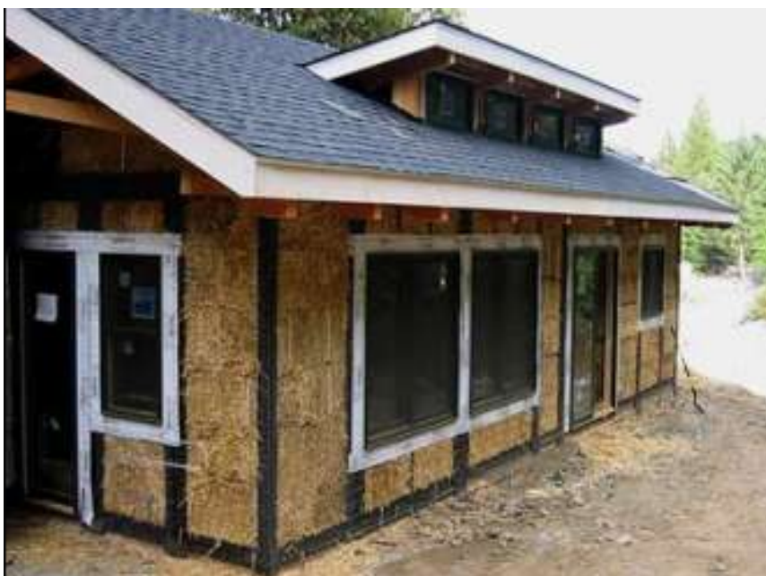
Slika 3.2 Izolacijska ispuna od slame
