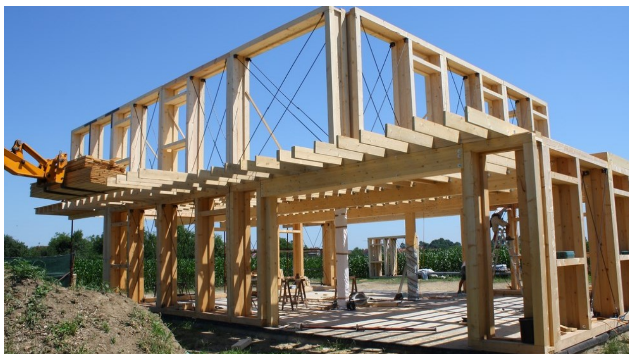
Slika 3.4 Drveni nosivi sustav
