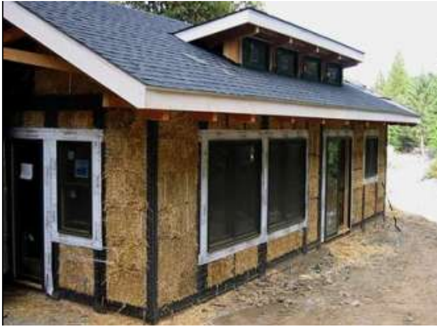
Slika 3.2 Izolacijska ispuna od slame
