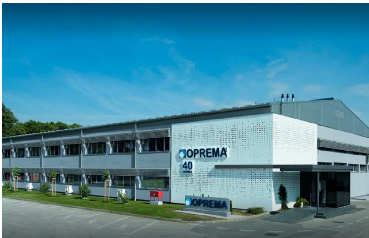
Slika 8. Zgrada Opreme d.d.
