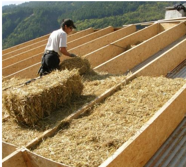
Slika 3.13. Postavljanje slame na krov
