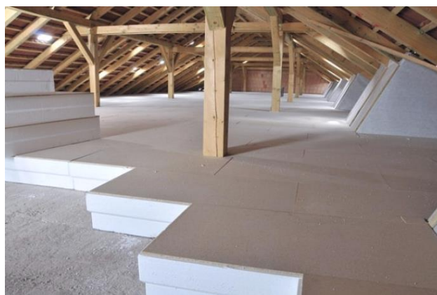
Slika 3.11. Postavljanje EPS-a u potkrovlje
