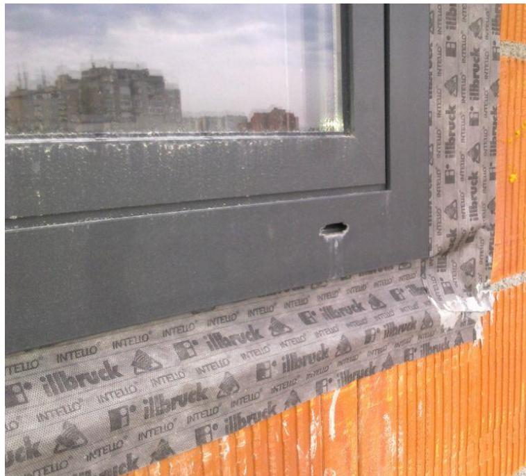
Slika 3.16. Montaža prema RAL smjernicama
