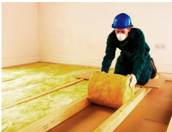
Slika 3.10. Postavljanje mineralne vune u sloj poda kao toplinsku izolaciju
