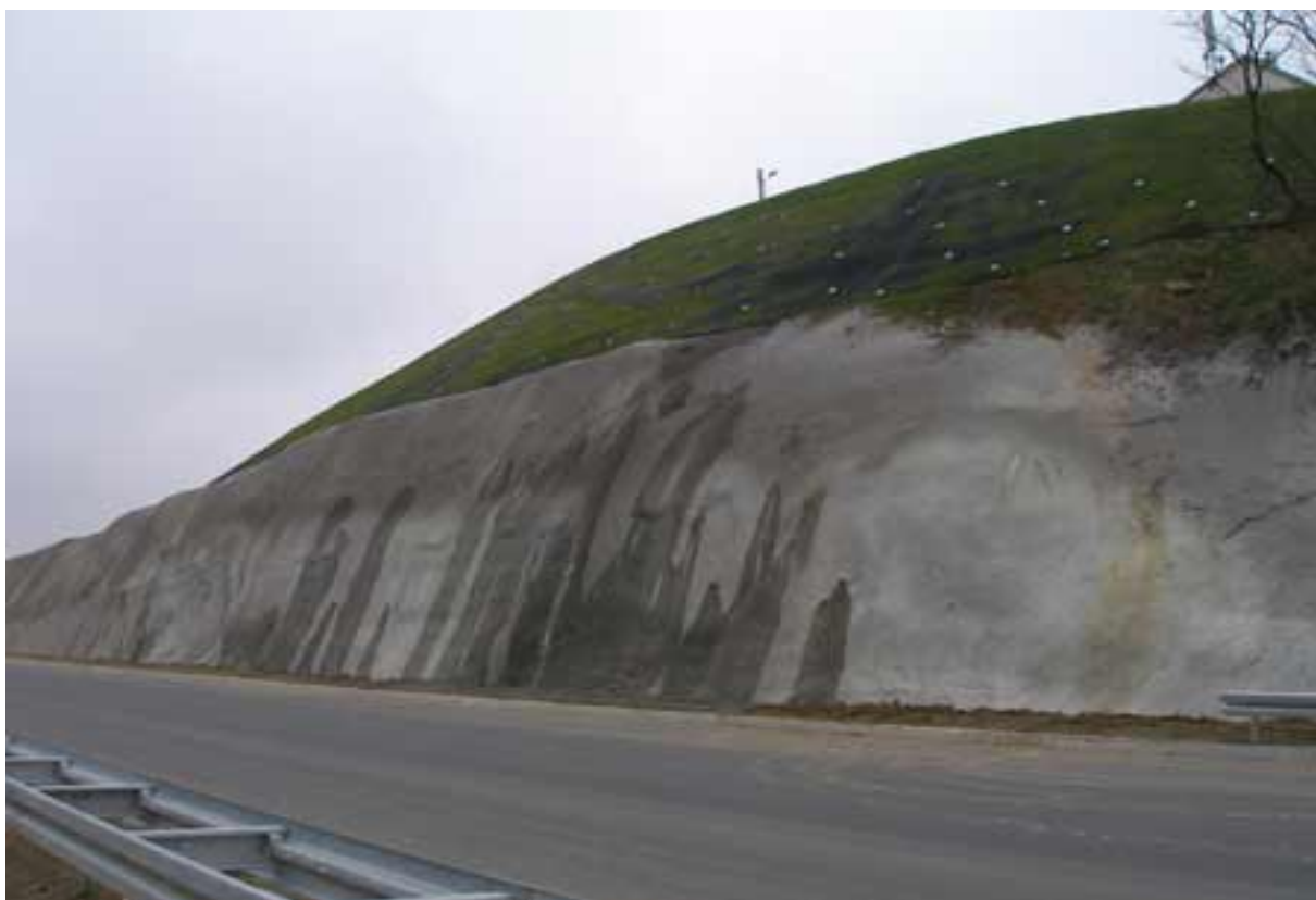
Slika 3. Prikaz mlaznog betona na jednom pokosu
