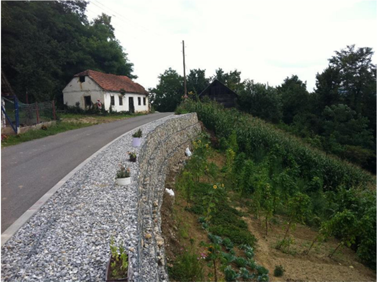
Slika 23. Izvedeni gabionski zid
