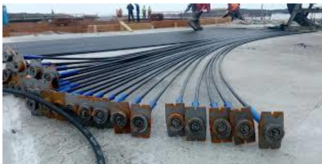
Slike 2.7. i 2.8. Unbonded kabeli sa sidrenim pločama
