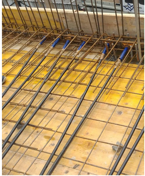
Slika 2.10. Pasivna usidrenja
