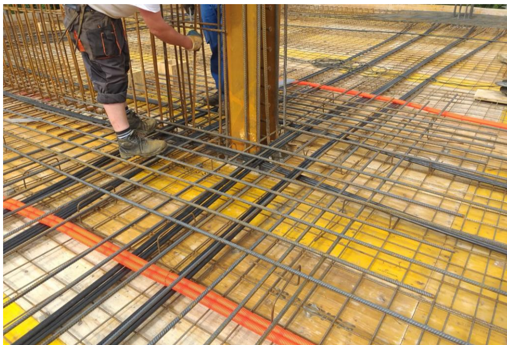
Slika 2.13. Slobodno vođenje kabela na gradilištu
