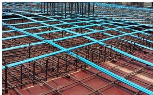
Slika 2.4. Unbonded tehnologija
