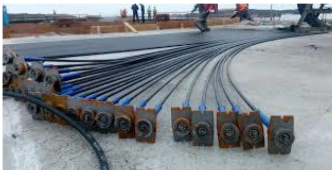
Slike 2.7. i 2.8. Unbonded kabeli sa sidrenim pločama
