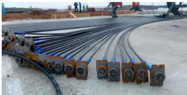
Slike 2.7. i 2.8. Unbonded kabeli sa sidrenim pločama
