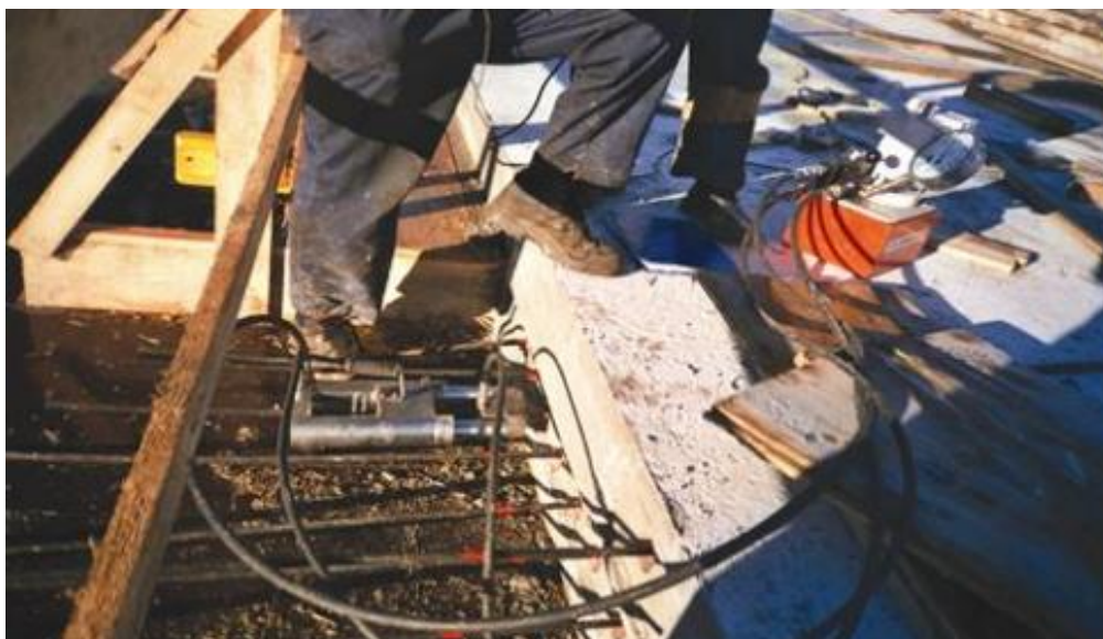
Slika 2.12. Unosi sile hidrauličkom prešom
