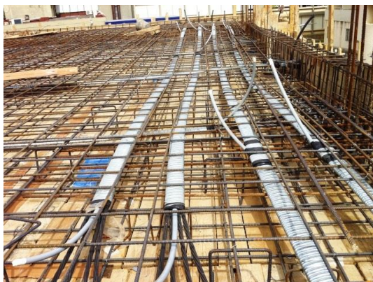
Slika 2.3. Bonded tehnologija
