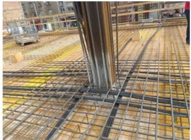
Slika 4.8. Problem proboja obuhvaćen i posjetom gradilištu
