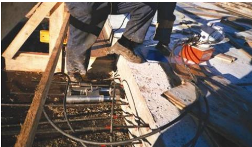
Slika 2.12. Unosi sile hidrauličkom prešom
