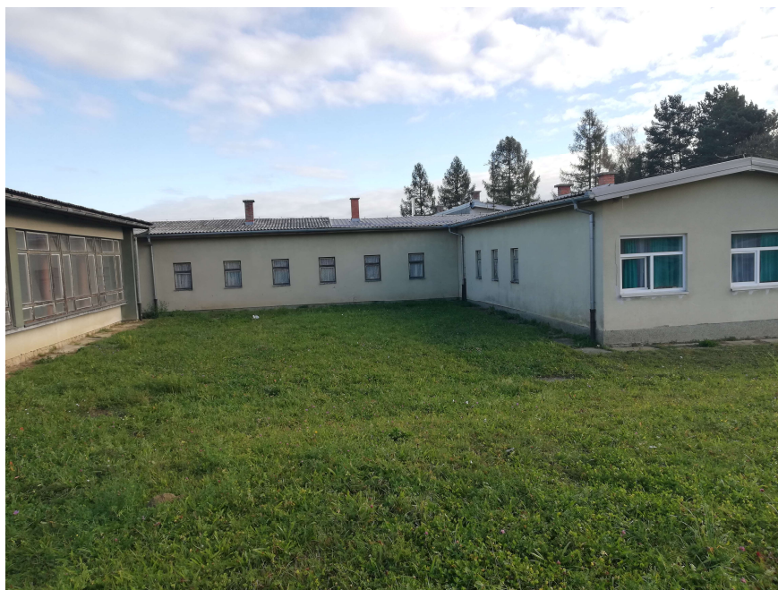
Slika 3.2 Jugozapadno pročelje zgrade
