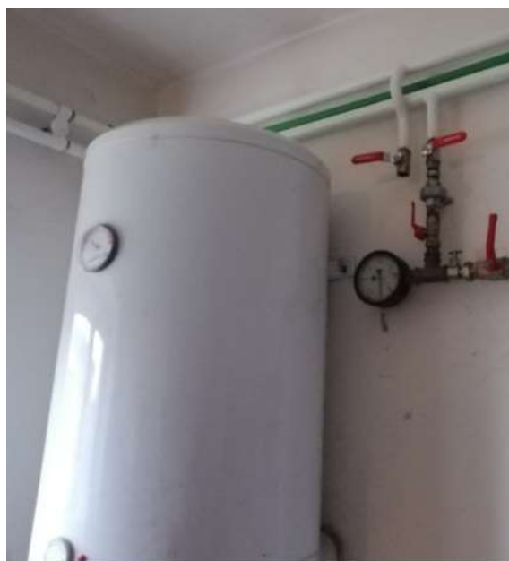
Slika 3.4.2 Postojeći spremnik za pripremu PTV-a
