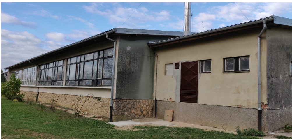
Slika 3.1 Ulazno(jugoistočno) pročelje zgrade i kotlovnica
