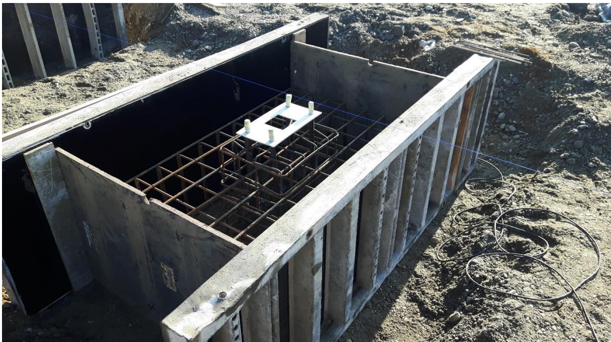
Slika 9. Oplata za temeljne stope
