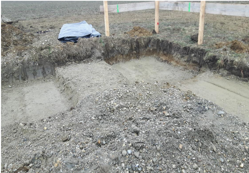
Slika 4. Strojni iskop jame za temeljne stope
