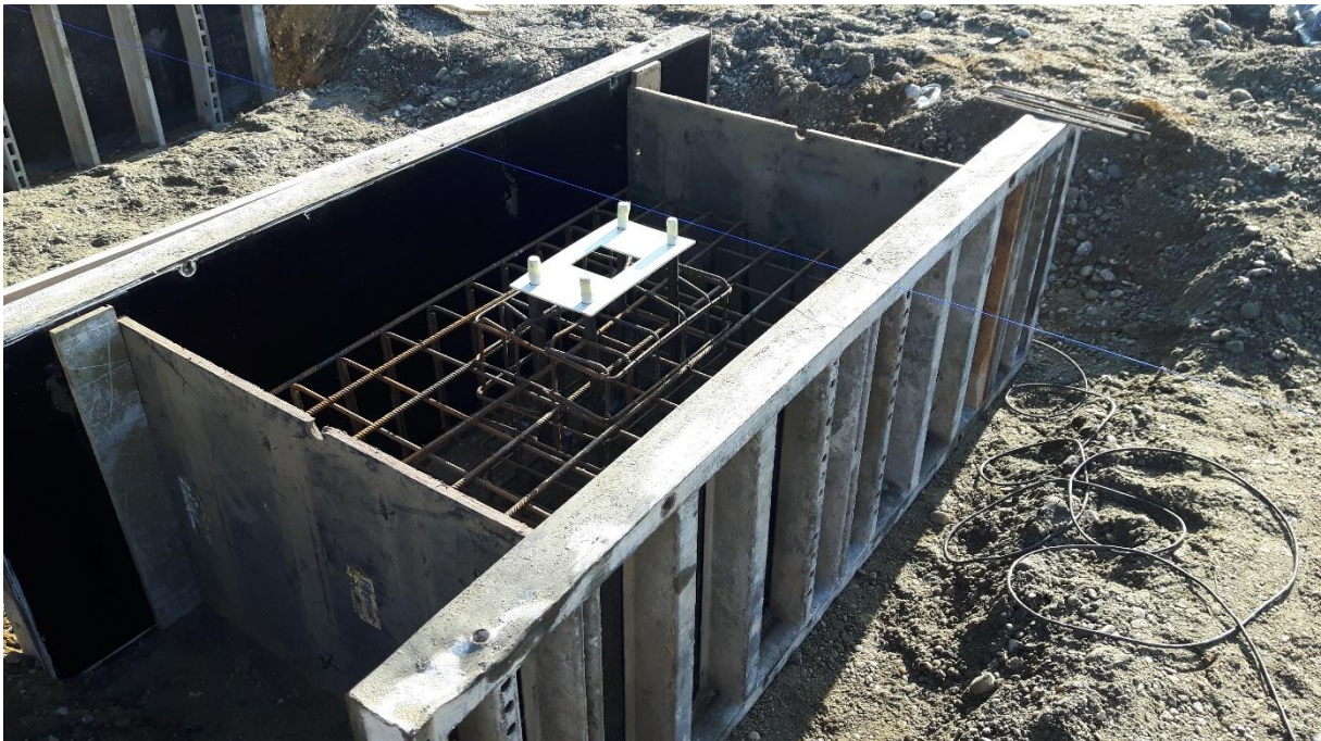
Slika 9. Oplata za temeljne stope
