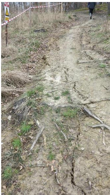
Slika 4.5. Vlačna pukotina uz čeonu rub glinokopa [1]
