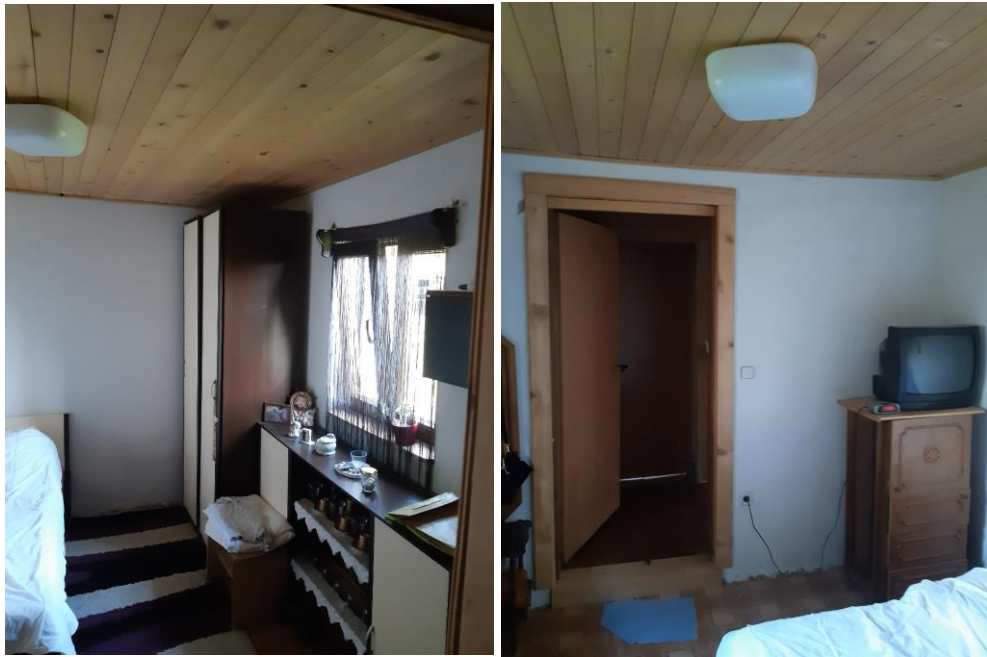
Slika 8. i 9. postojeće stanje spavaće sobe
