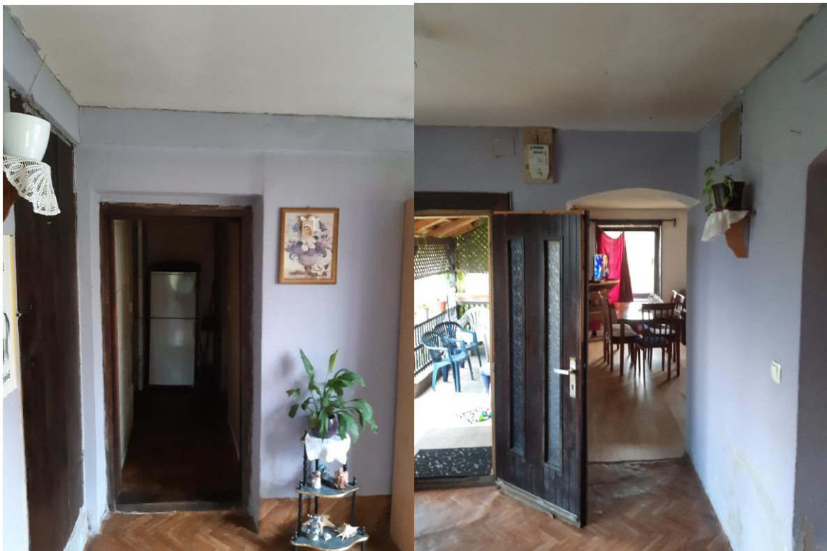
Slika 3. i 4. postojeće stanje hodnika
