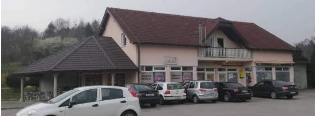
Slika 1 Sjeveroistočno i Jugoistočno pročelje
