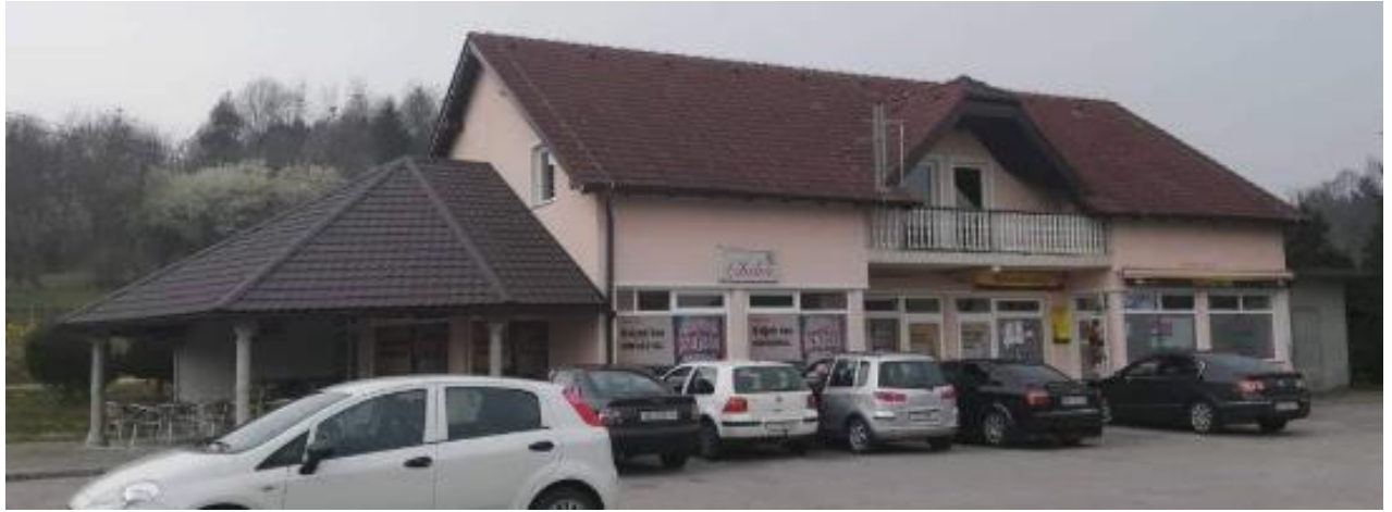
Slika 1 Sjeveroistočno i Jugoistočno pročelje
