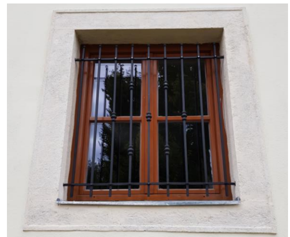
Slika 3.7.4. Restaurirani kameni prozorski okvir
