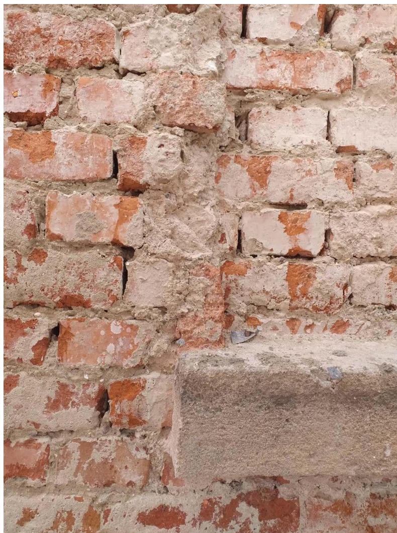
Slika 3.2.2. Stanje zida nakon skidanaja žbuke
