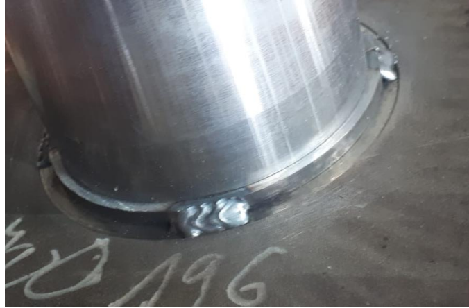
Slika 3.9 Zavarivanje poluprstena (osiguranje)
