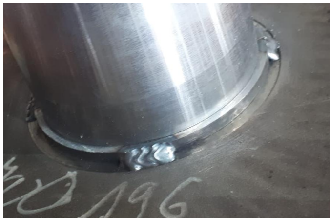
Slika 3.9 Zavarivanje poluprstena (osiguranje)
