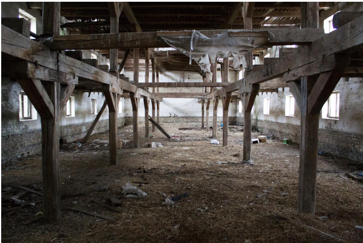
Slika 3.14 Trenutni izgled unutrašnjosti hangara za skladište sjemena (IPK Klisa)
