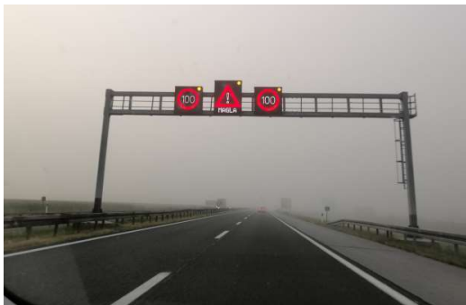
Slika 35. Svjetlosni znak za upravljanje prometom na autocesti A3.
