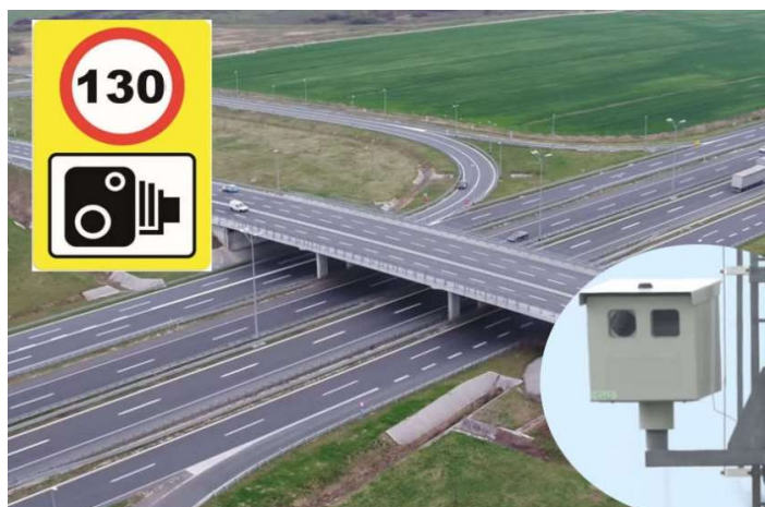
Slika 28. Prikaz nadzorne kamera na autocesti
