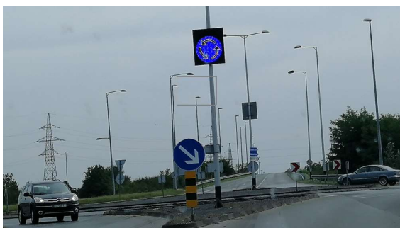
Slika 10. Primjer LED signalno promjenjivih znakova za kružni tok
