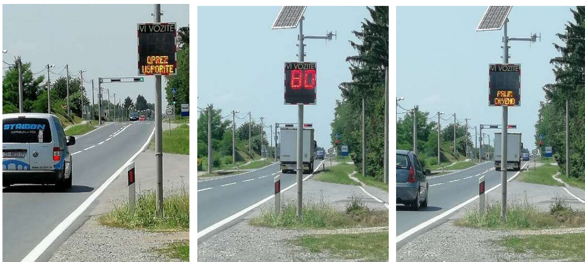
Slika 30. Svjetlosni znak za upravljanje prometom na D2 kod Virovitice.
