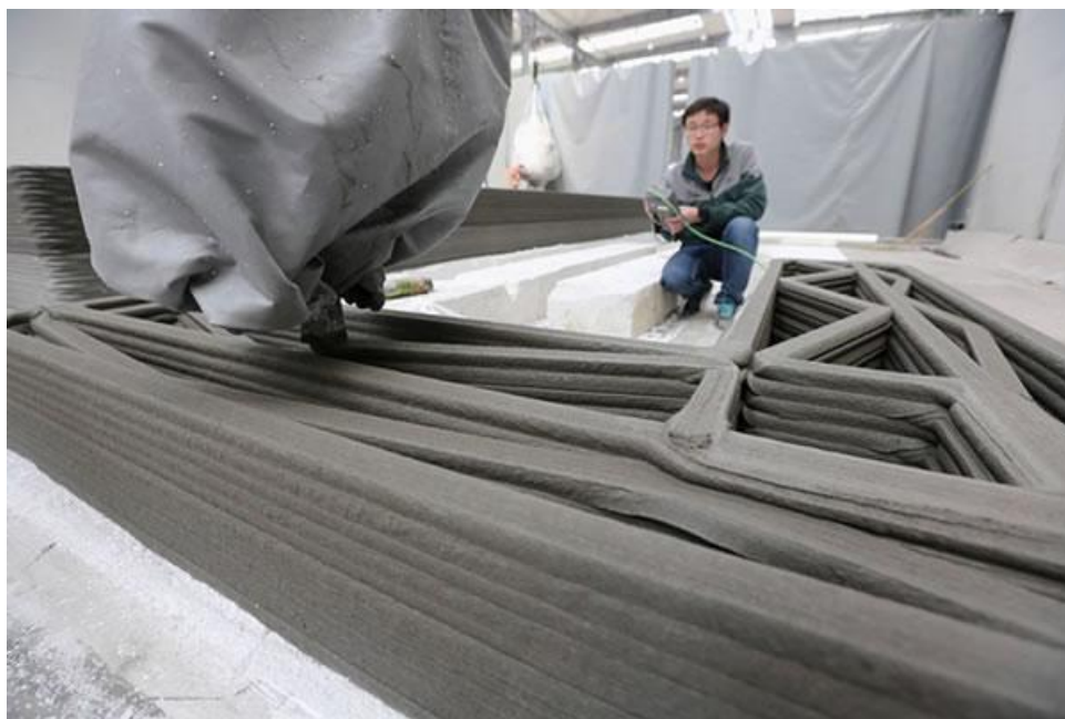
Slika 19. Postupak izrade stambenog objekta 3D pisačem
