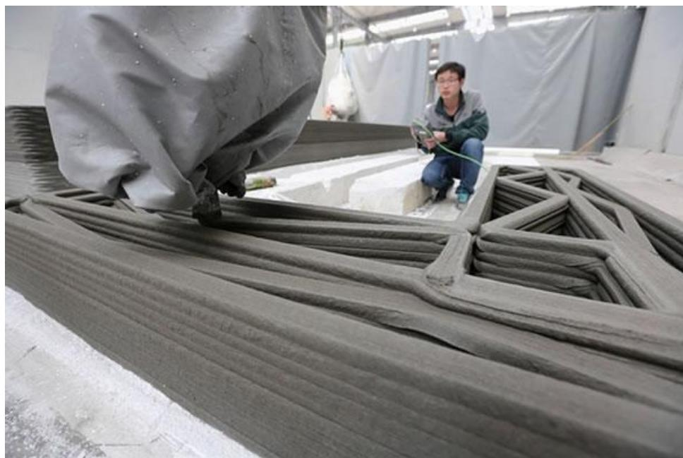
Slika 19. Postupak izrade stambenog objekta 3D pisačem
