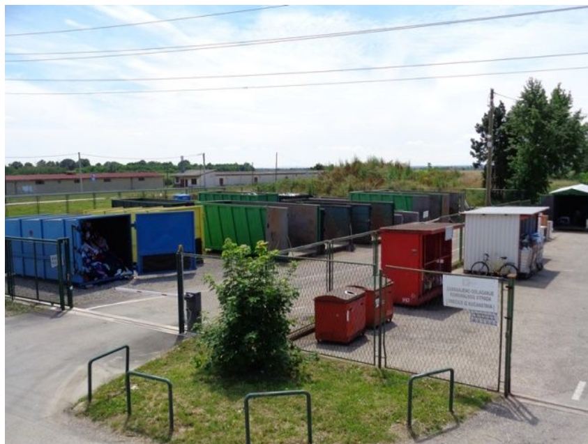
Slika 2. Reciklažno dvorište u Velikoj Gorici
