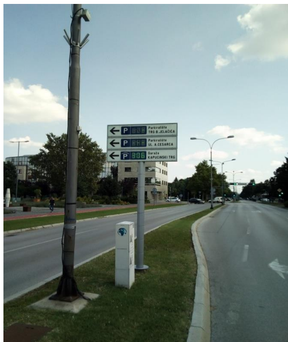
Slika 12. UPGS na lokaciji Ulica Zrinskih i Frankopana
