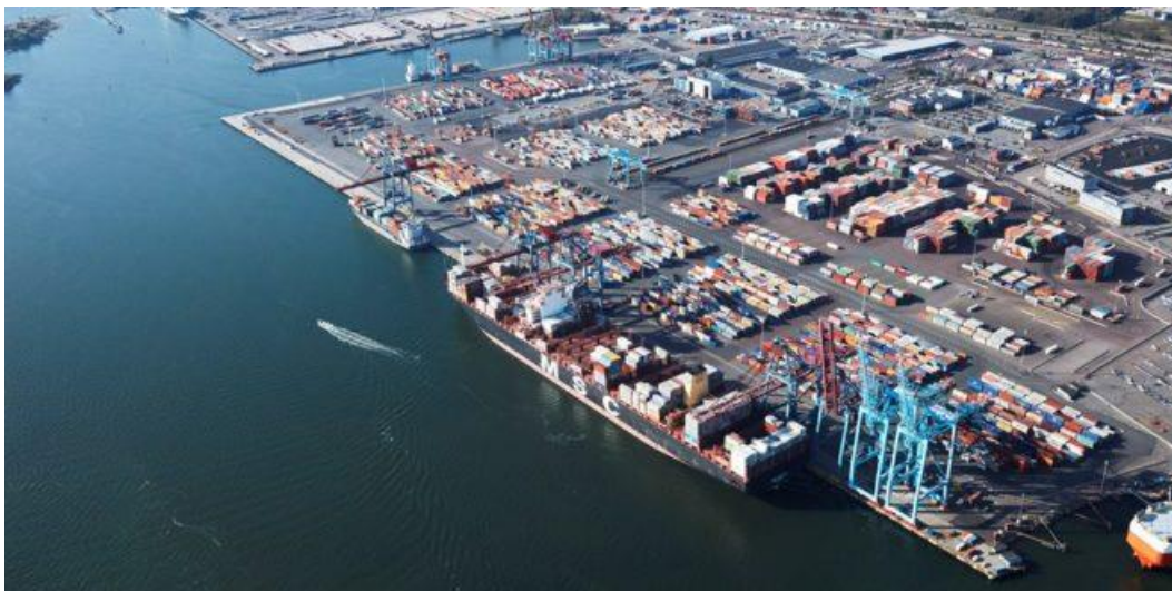
Slika 10. Intermodalni terminal Gothenburg
