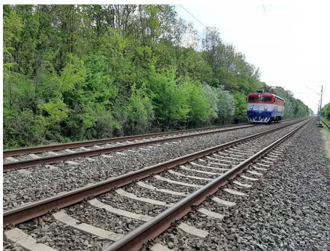
Slika 3.8. Željeznička pruga -nosač na elastičnoj podlozi; Izvor: https://www.zeljeznice.net/forum/index.php?forum/11-infrastruktura/
