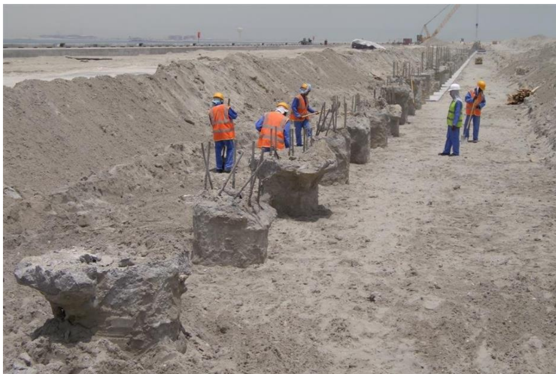
Slika 3.4. Piloti na koji će se izgraditi temeljni nosač za kransku stazu lučne dizalice; Izvor: https://mapio.net/pic/p-2522726/
