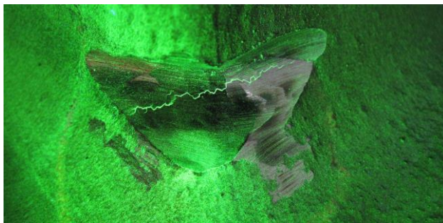
Slika 7 Pukotina zavara detektirana MT [7]
