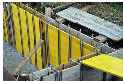
Slika 3.3. Primjer izvedbe AB zida
