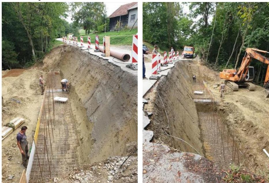
Slika 6.10. Izrada temelja za gabionski zid
