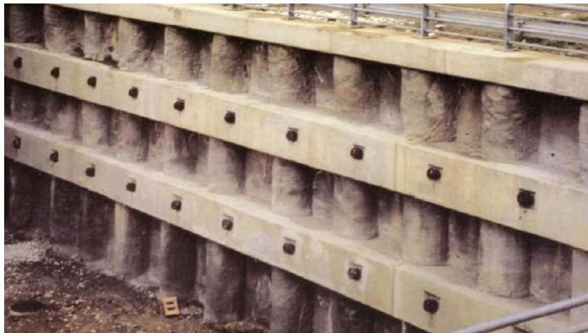
Slika 2.8. Prikaz otkopane konstrukcije izvedene pilotnim stijenama
