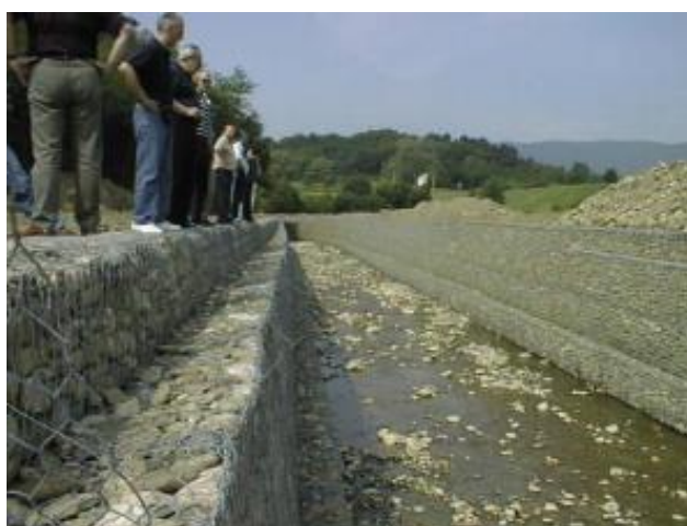
Slika 2.3. Vertikalne gravitacijska obaloutvrda od gabionskih košara [6]
