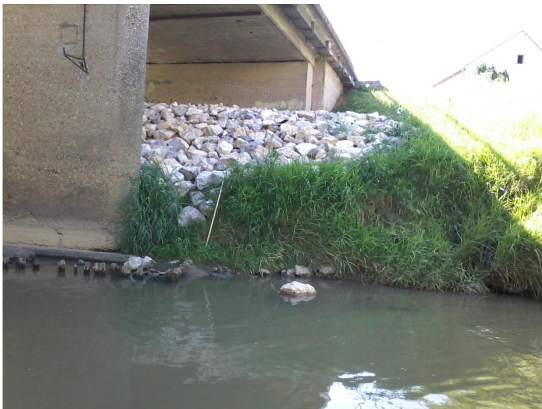
Slika 3.2. Obaloutvrda od kamena (rip-rap) uz most na lijevoj obali [8]
