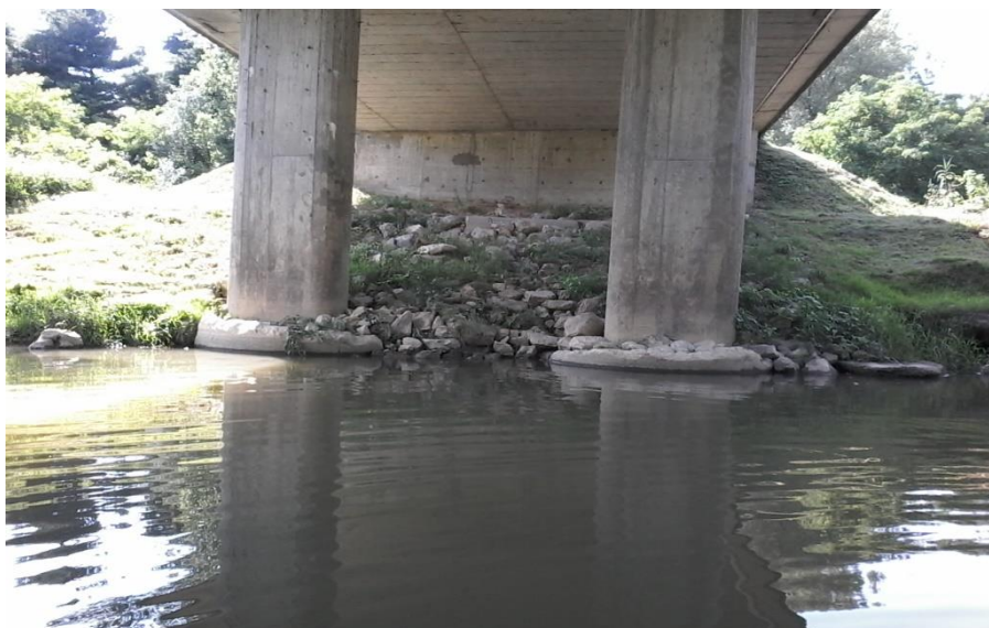
Slika 3.7. Kosa obaloutvrda od kamena (rip-rap) uz most[8]
