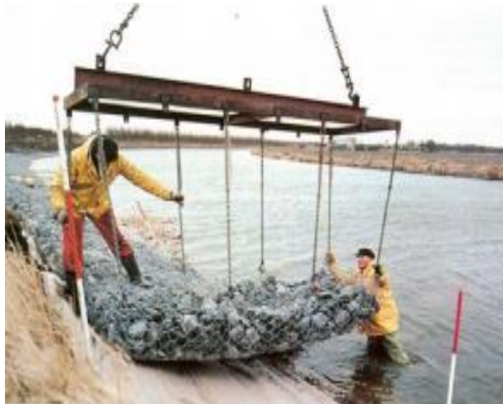
Slika 2.6. Kosa obaloutvrda s oblogom od gabionskih madraca [6]
