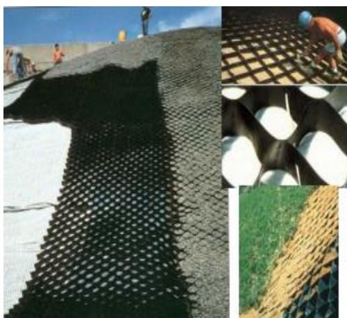
Slika2.8. Kose obaloutvrde s oblogom od sintetskih materijala ispunjenih zemljom[6]
