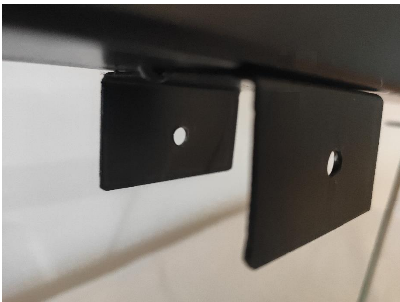
Slika 4.2 Zavareni komadi U profila s donje strane grede
