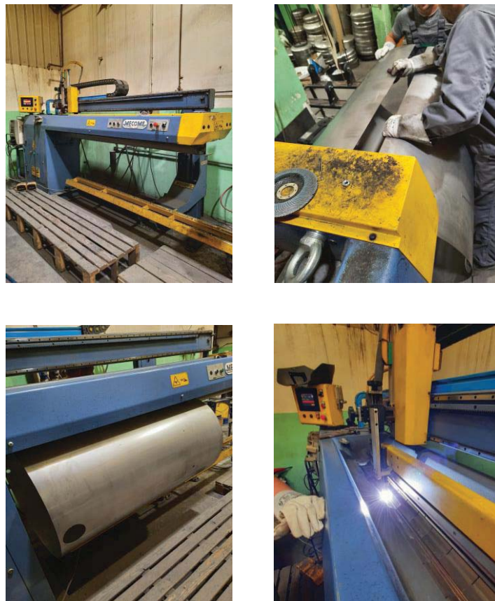
Slika 46. Postupak uzdužnog zavarivanja plašta
