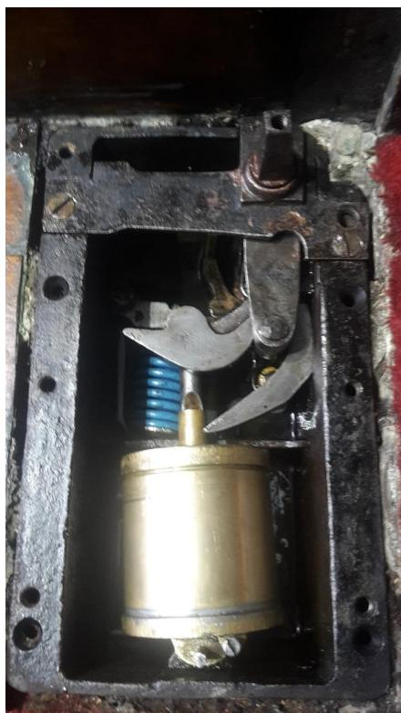
Slika 3.1: Jednoradna podna opruga za zatvaranje vrata [7]
