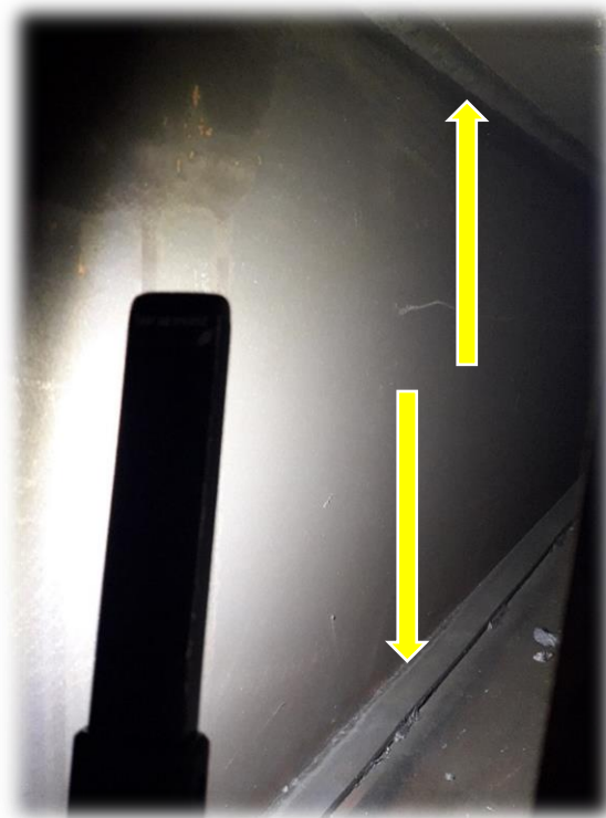
Slika 31. Dodavanje flaha i vizualna kontrola zavara [4]
