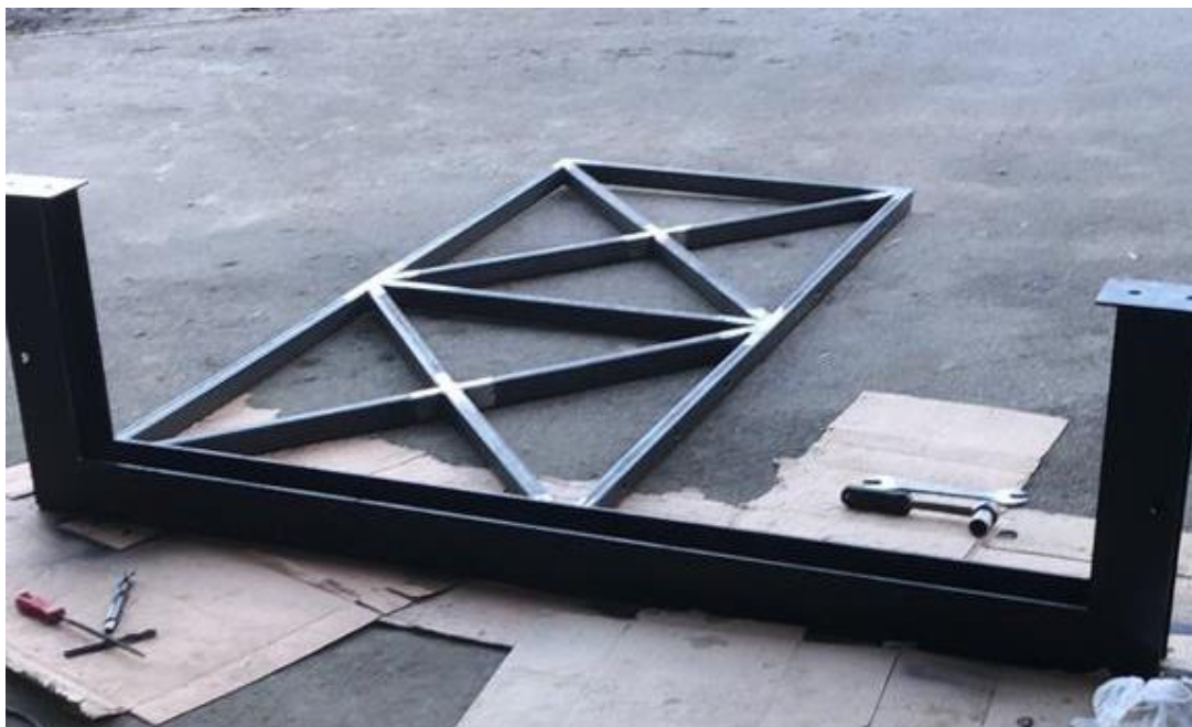
Slika 77. Probna montaža nosive konstrukcije i konzolne potpore
