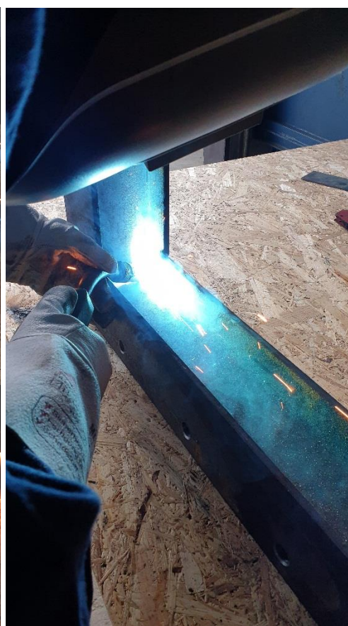
Slika 71. Zavarivanje pozicija konzolne potpore
