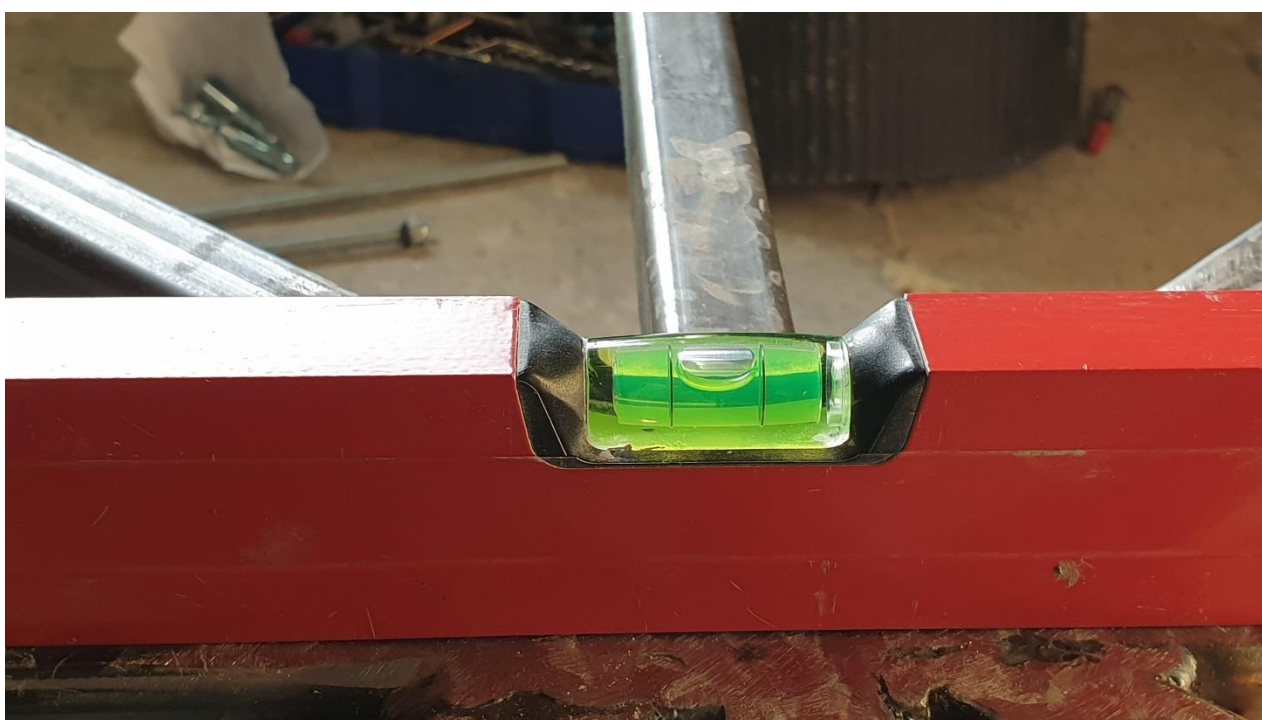
Slika 83. Provjera ravnosti površine nosive konstrukcije
