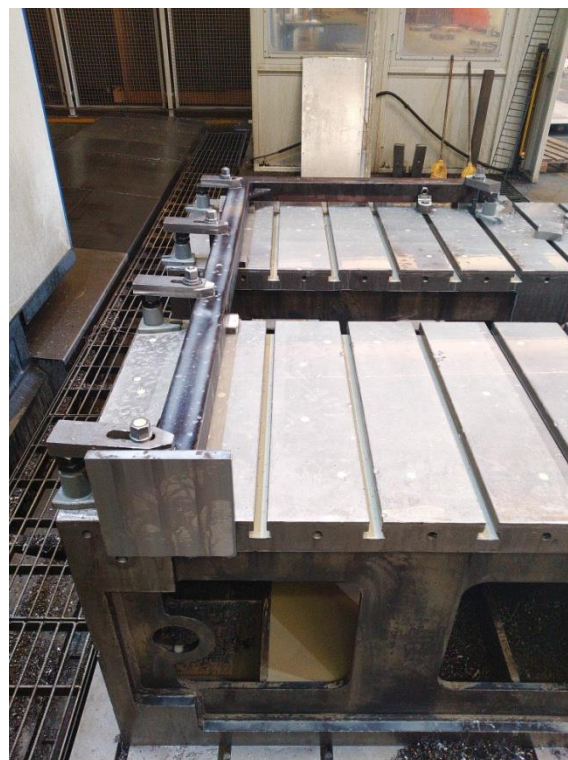
Slika 3.4. Strojna obrada konstrukcije
