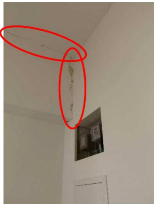
Slika 5.33. - Vertikalne pukotine zidnih gipskartonskih obloga
