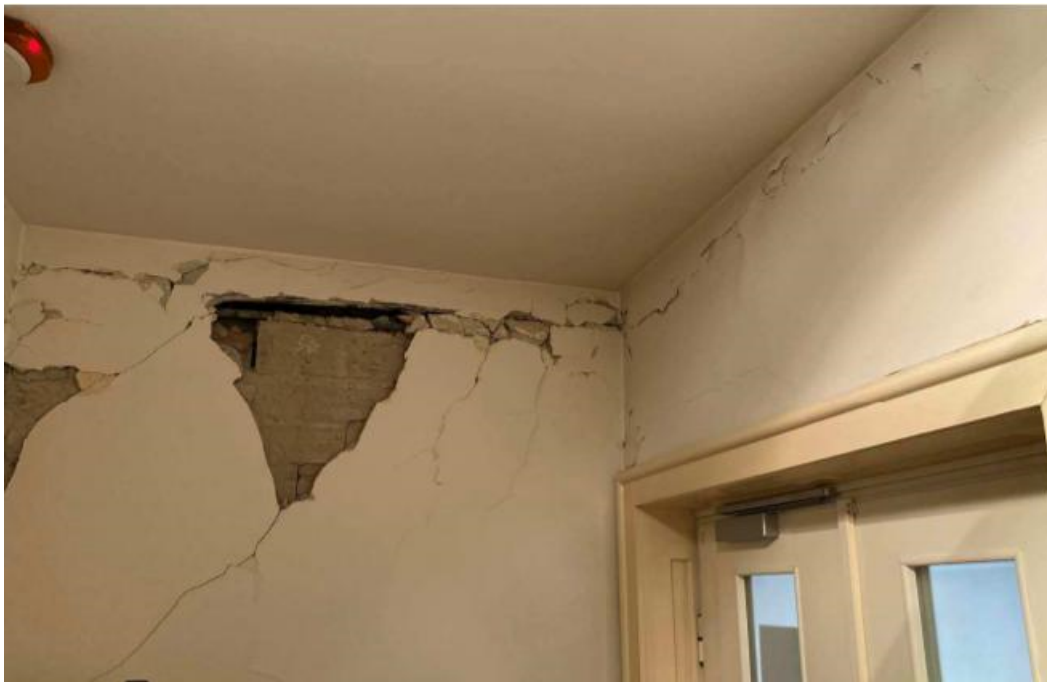
Slika 5.10. - Ulaz u predmetni stan, pogled na pregradni zid koji se naslanja na unutarnji nosivi zid
