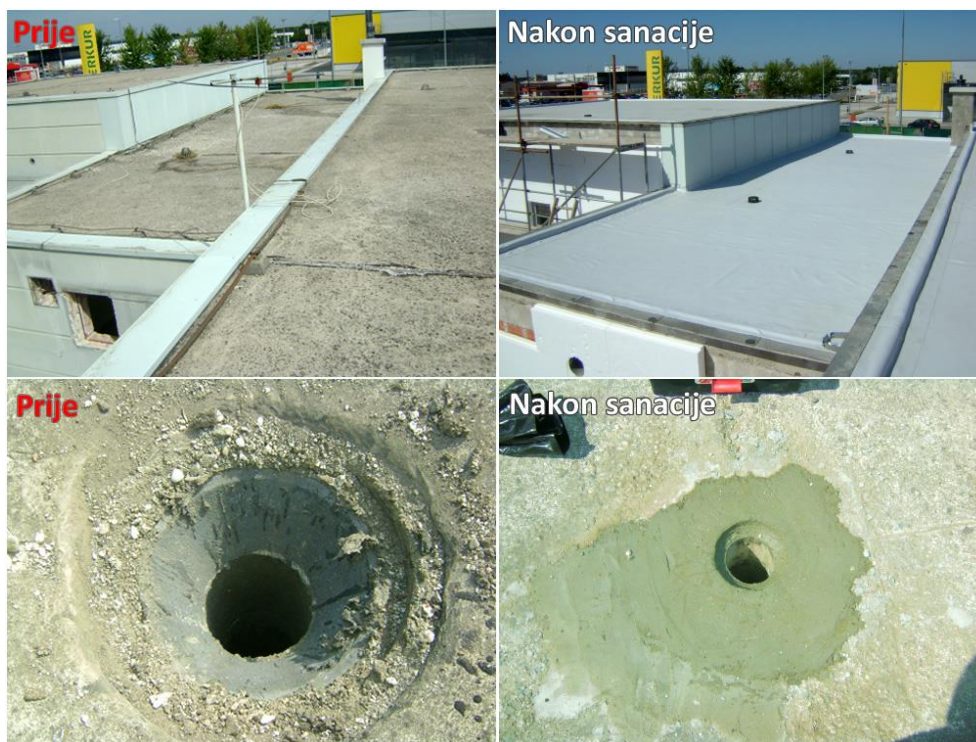
Slika 34. Sanacija ravnog krova na benzinskoj postaji u Čakovcu
