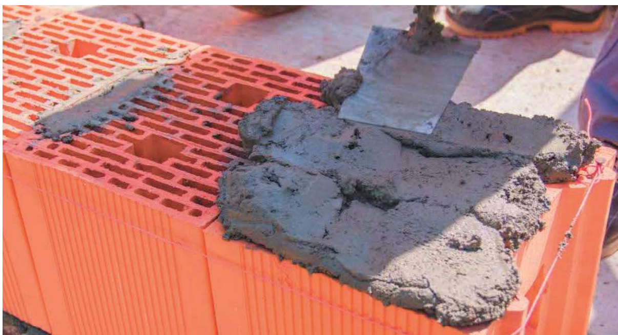
Slika 5 - Zidarski radovi, zidanje opekom i svježe izmiješanim motrom , [Izvor: https://www.wienerberger.hr/ ]
