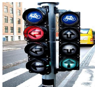
Slika 30. Semafori koji daju prioritet prolaska biciklima
